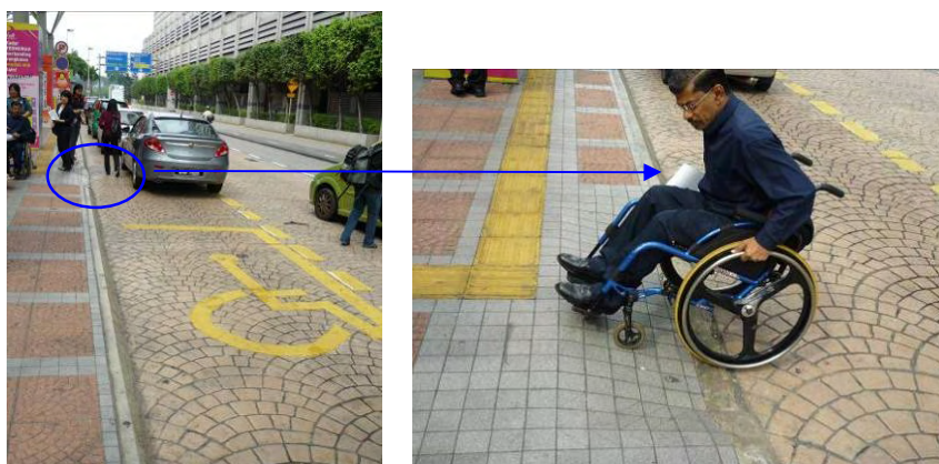
写真 4-1-2 車いす使用者用駐車場から歩道へのアクセス
