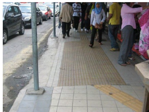
写真 2-5-18 KL セントラル駅接続歩道
