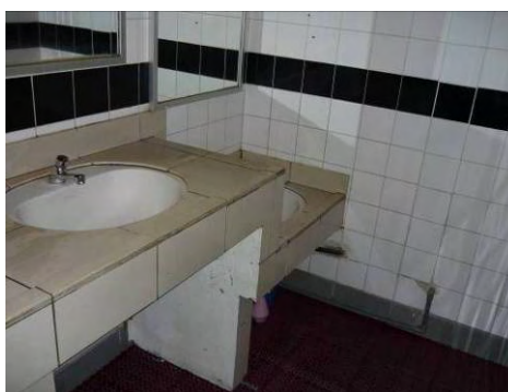
写真 4-1-3 クラナジャヤ駅の車いす対応手洗い
