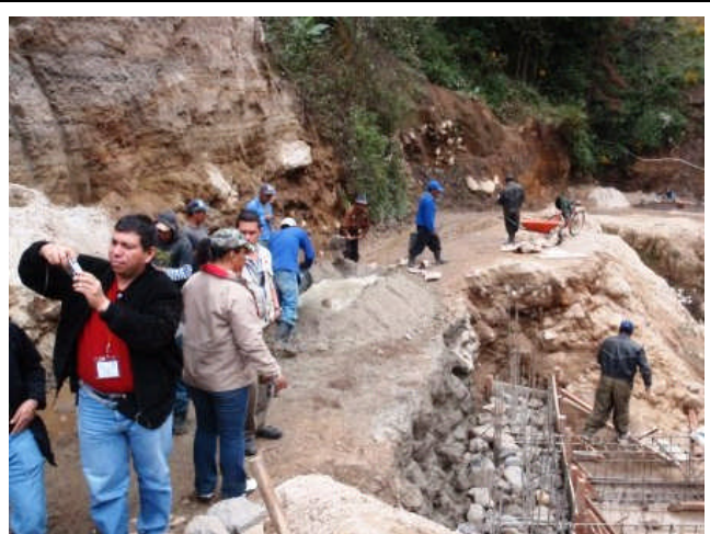
コミュニティによる小橋梁建設現場。
