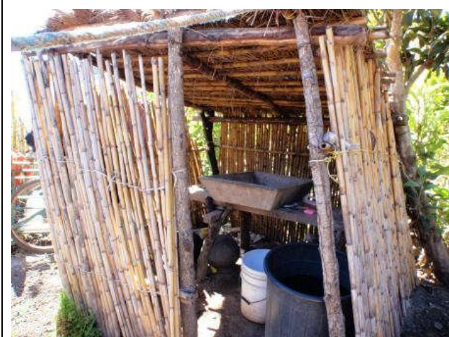
KAIZEN チームが最初に取り組んだ洗濯場の改善成果。村落に自生している植物の茎を壁に利用している。
