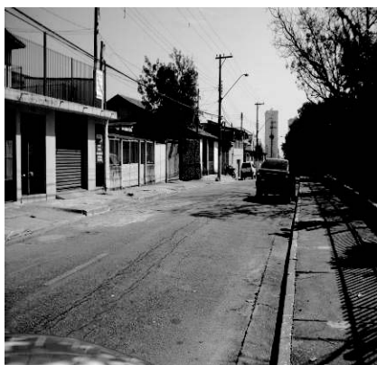
配水管更新予定道路
