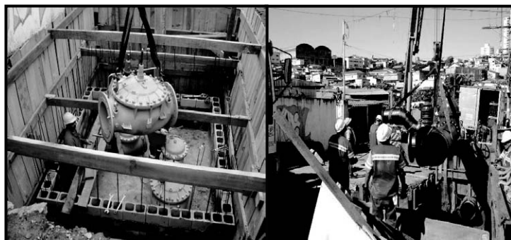
VRP 設置工事
