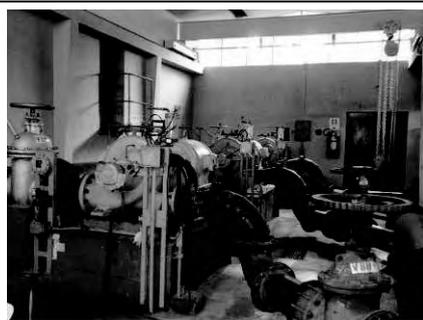
上水ポンプの運転を、配水管内の圧力に応じた回転数制御方式とすることにより、高架タンクの廃止は可能であり、省電力が図れる。
