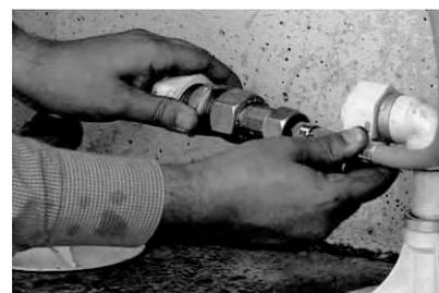
現在の圧力を確認する。その後分水栓のバルブを閉止する。水圧の推移を圧力ゲージで観測する。このテストで漏れがないことを確認する。
