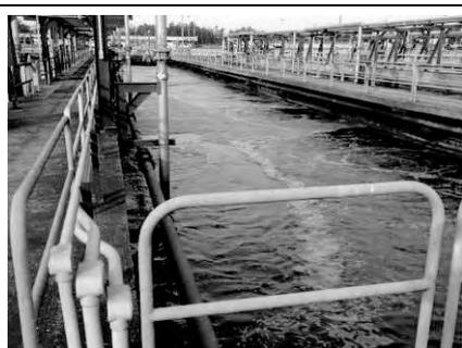
当処理場には、曝気槽用と沈砂池用に曝気装置（ブロワー）が2箇所設置されている。
