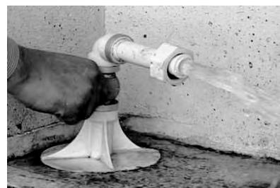
**Step2: 通常圧力による水圧テスト(予圧テスト)**
