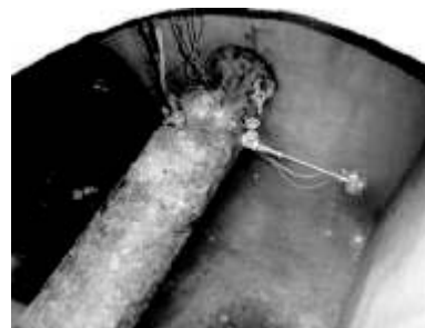
400mm 配水管に取り付けた 電磁流量計
