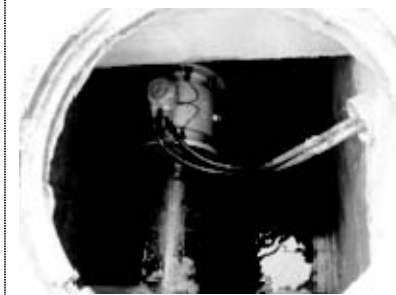
250mm の DMC 流入点の 電磁流量計
