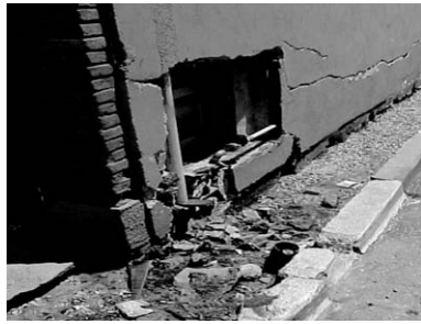
UMA(壁埋め込み式メーター) の設置工事
