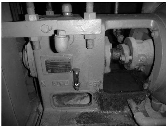
Hình 3.2.44 Máy bơm bùn ở bể lắng sơ cấp
