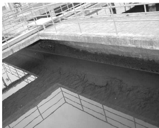
Hình 3.2.40 Bể mặt nước khi máy sục khí ngừng hoạt động
