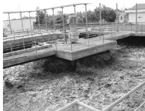
Nguồn: nhóm nghiên cứu JICA Hình 3.2.39 Hoạt động của máy sục khí
