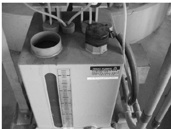
Hình 3.2.48 Bình hóa chất
