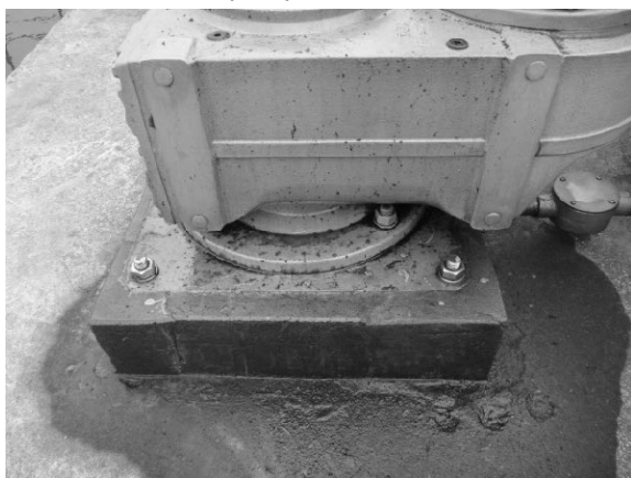
Hình 3.2.42 Dầu bị chảy ra ngoài
