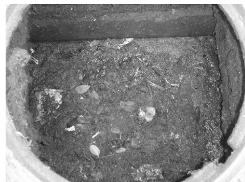
Nguồn: nhóm nghiên cứu JICA Hình 3.3.5 Hố ga cho nước mưa
