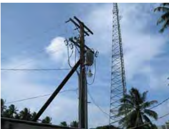
マジュロ市内の配電設備 1
