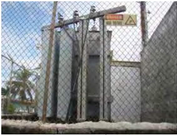
(ジェンロック変電所)
