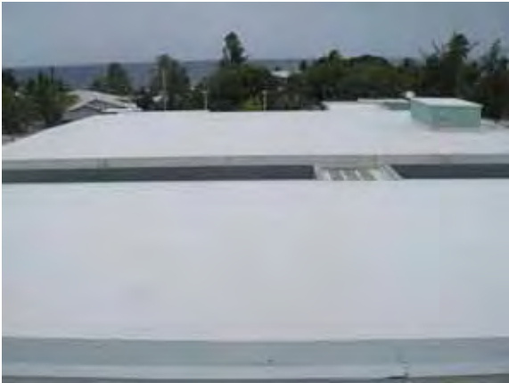
マジュロ病院屋根部
