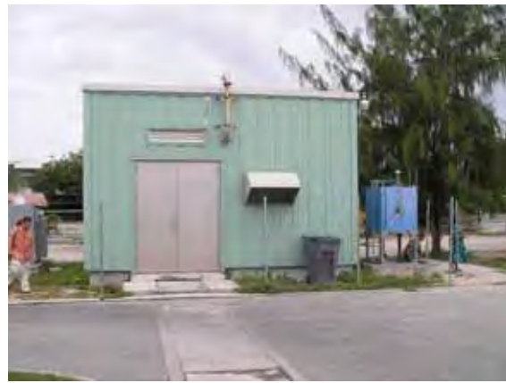
マジュロ病院変電室
