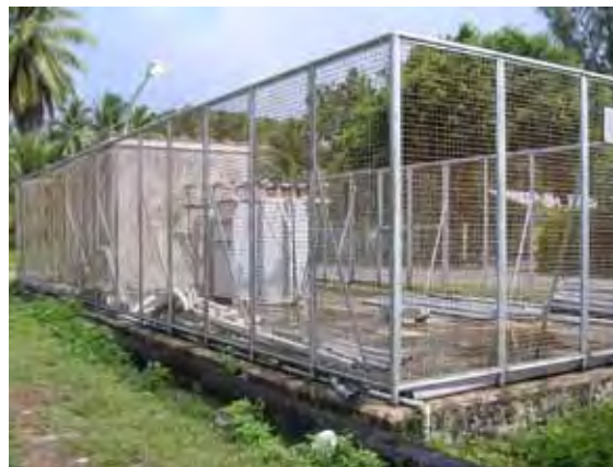
マジュロ市内の配電設備 2
