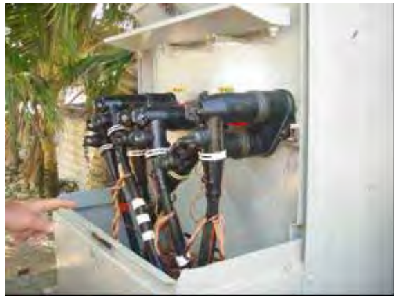
(開閉器ブッシング引出部)
