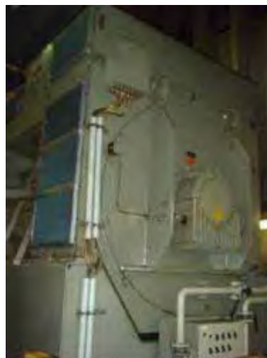
写真 2.1.4-1 マジュロ発電所外観 (STATION-1, 2) およびディーゼル発電機 (#7 号機)
