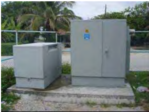
(開閉器および地上据置型変圧器)
