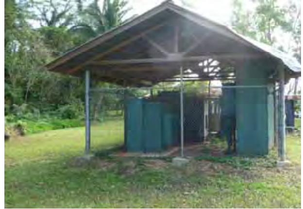
低圧連系点となる既設 Transformer Station No.4
