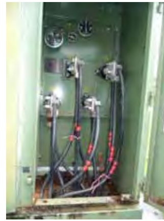
既設低圧分電盤内の連系点
