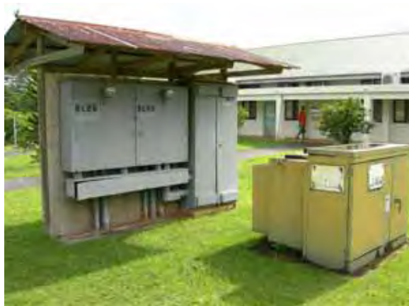
パッドマウント型変圧器及び電力計量箱
