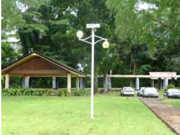
中国の支援によって設置された PV 街路灯
