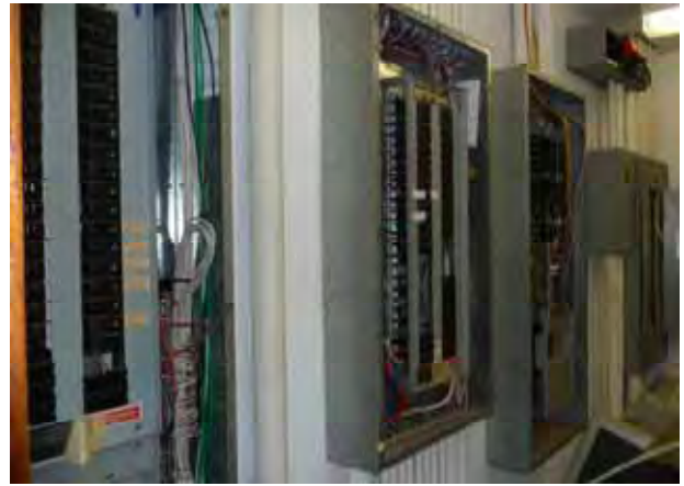
大統領執務室既設配電盤
