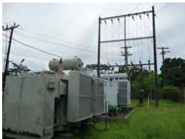
ナンポウマル発電所構内昇圧変電所
