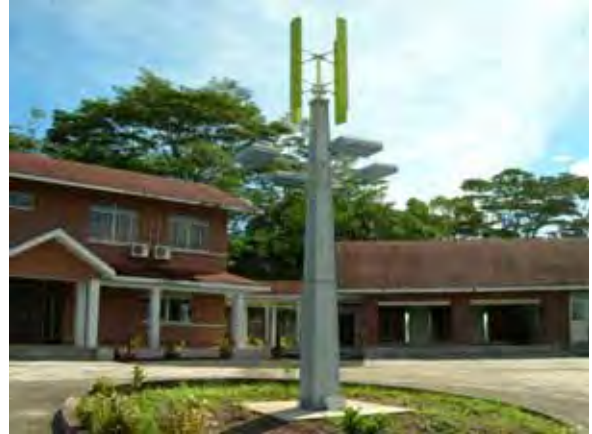
日本の団体(NGO)によって設置された PV 街路灯
