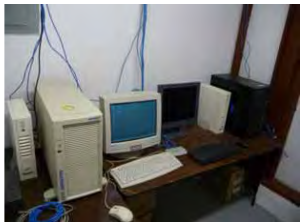
遠隔監視システム専用サーバー設置予定地
