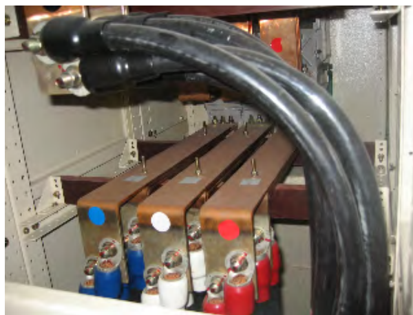
図 3.2.2-5 「パラオ国際空港」における主配電盤内部
