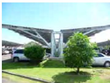
PV モジュール
