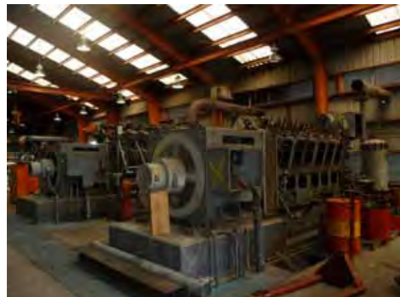
マラカル発電所
