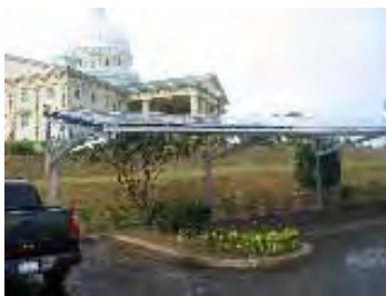
駐車場 PV モジュール
