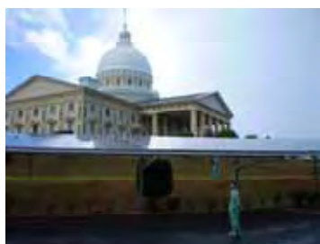
PV モジュール
