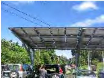
駐車場設置 PV モジュール
