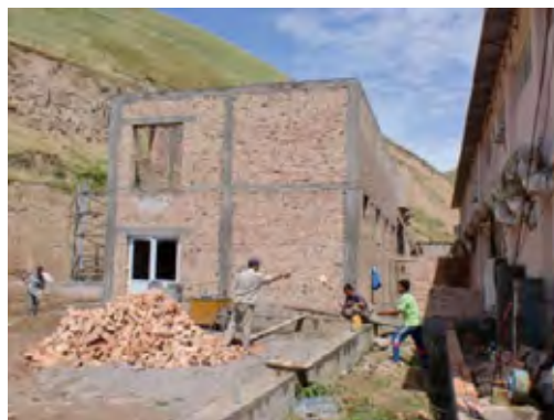
Фото 3-42 Строящееся здание. Полная реконструкция
