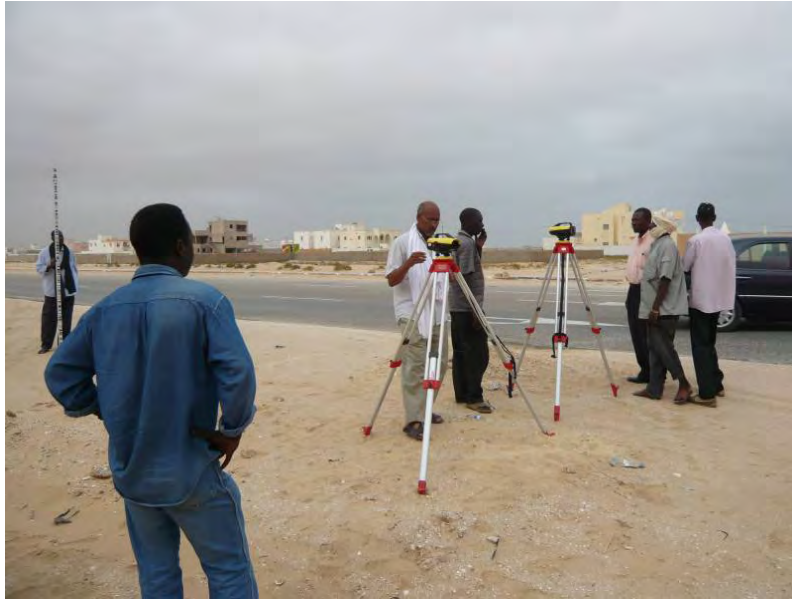
Figure 2.10 Formation en nivellement
