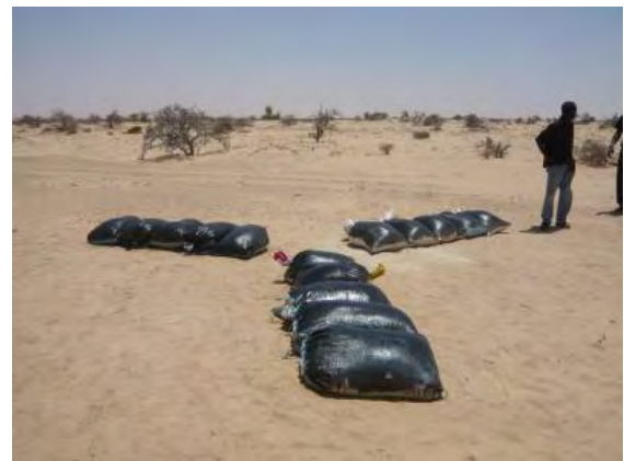
Figure 2.5 Mise en place de signal aérien
