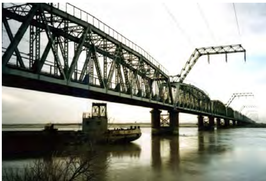
Мост Туркменабад – Фараб через реку Амударья
