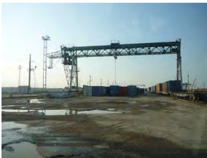
Контейнерная станция Кипчак
