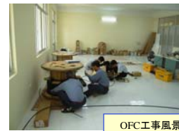
OFC工事風景
