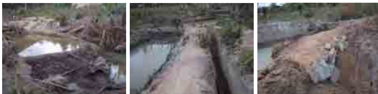
池の造成作業（2008年2月）
