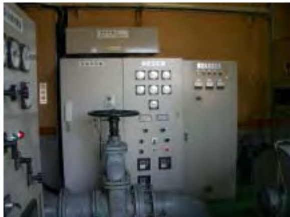
ປະຕູນ້ຳແບບ Sluice Valve
