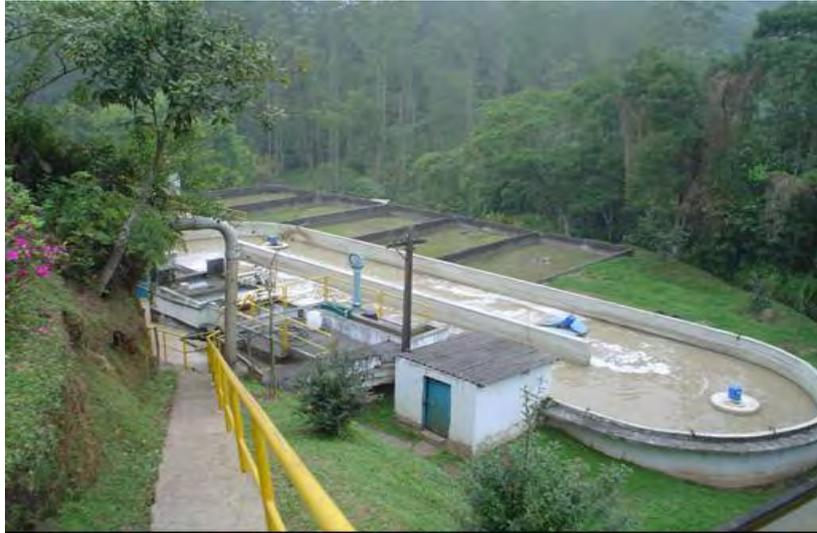
**Photo 6.4.1 Condições de Operação do Valo de Oxidação da Fábrica da Yakult**
