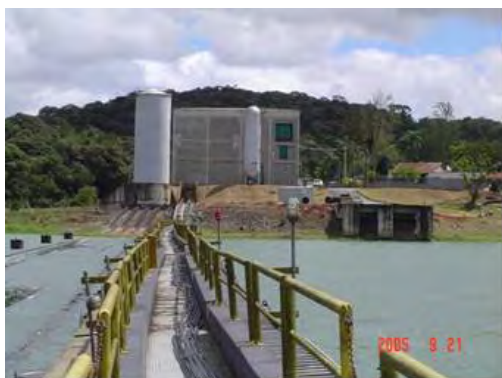
Foto 4.3.8 Estação elevatória em terra firme.
