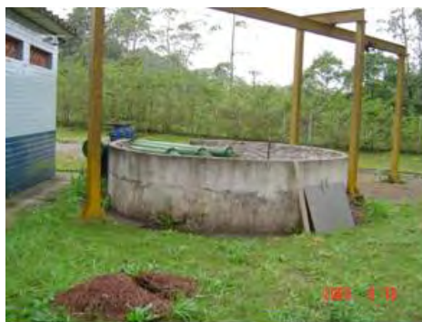
Foto 4.3.4 Utilização do poço de captação de água
