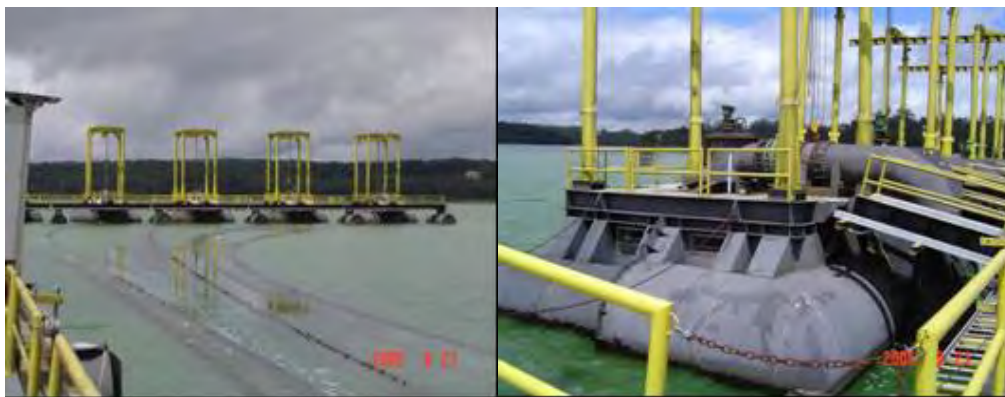
Foto4.3.7 Estação bombeamento flutuante.
