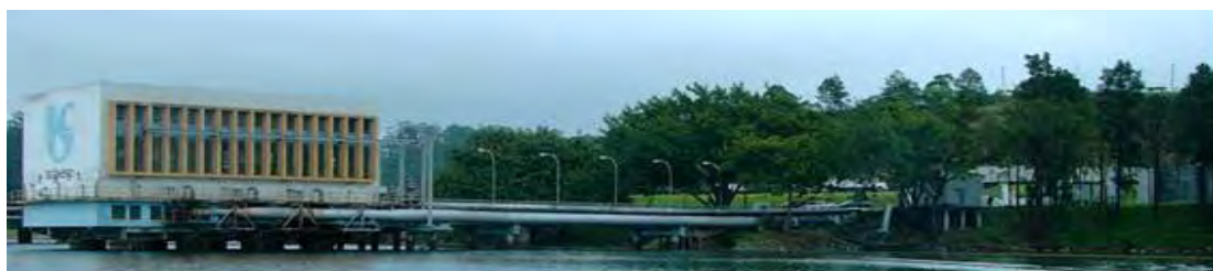
Foto 4.3.1 Vista panorâmica do terminal de captação de água e casa das bombas (à esquerda)
