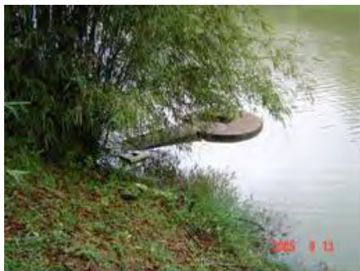
Foto 4.3.5 Ponto de captação
