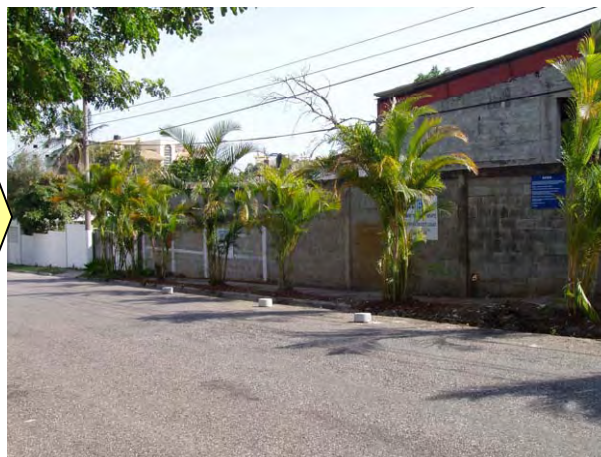
Calle San J. Bautista de la Salle frente a zona militar
