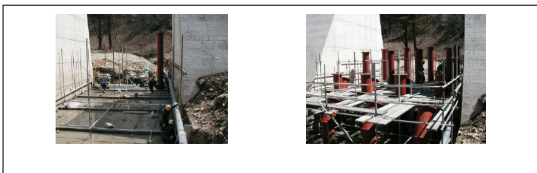
足場組立状況
