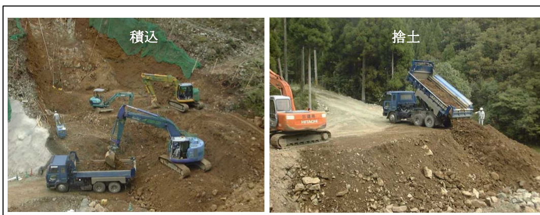
土砂の運搬・搬出・捨土の状況
