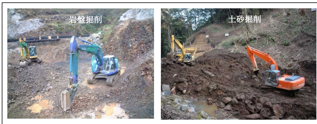
地盤ごとの掘削方法と使用機材の状況
