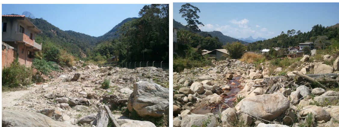
図 1.2.6 土石流痕跡の調査
