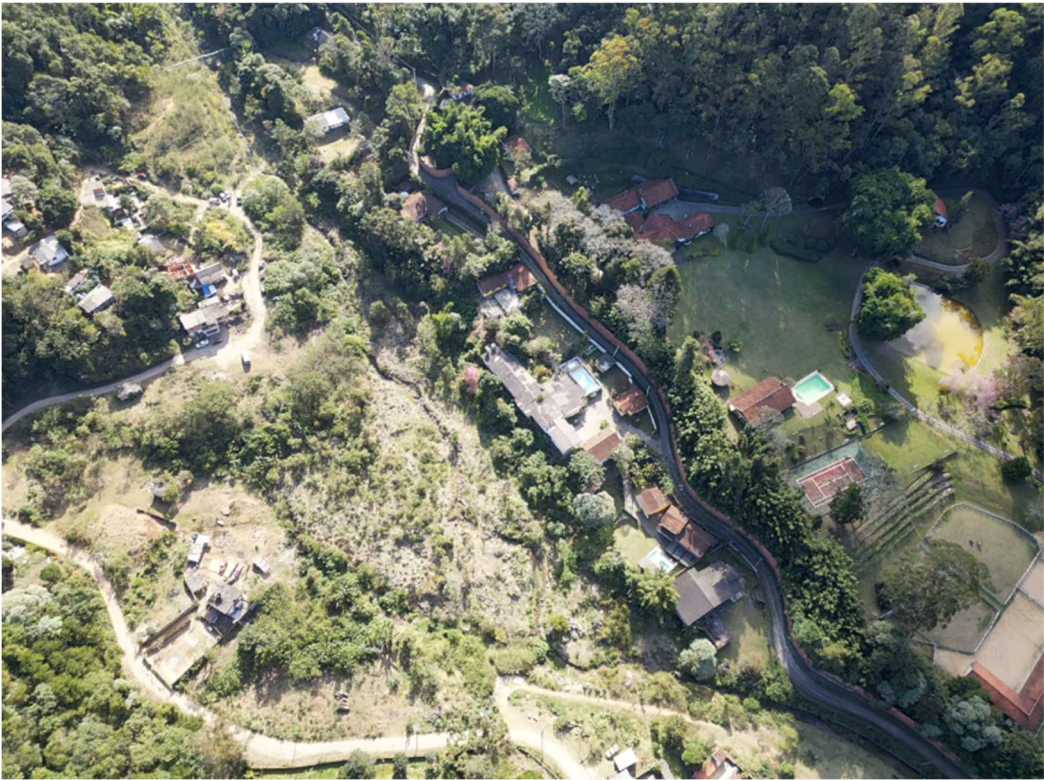
図 1.7.9 遊砂地計画箇所の状況
