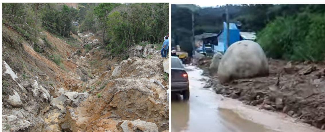
図 2.4.2 2011 年土石流時の巨礫の堆積状況（左：流域内、右：道路上）
