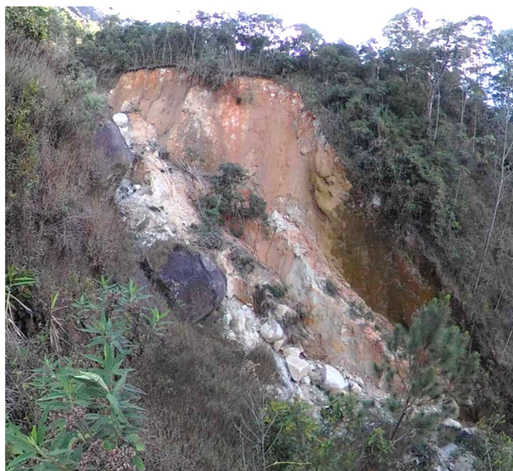
図 1.3.5 斜面に露出する風化残留土と溪床に堆積した石礫
