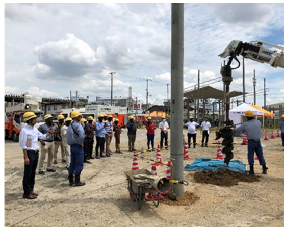
7/31AM 穴掘建柱車の実演
