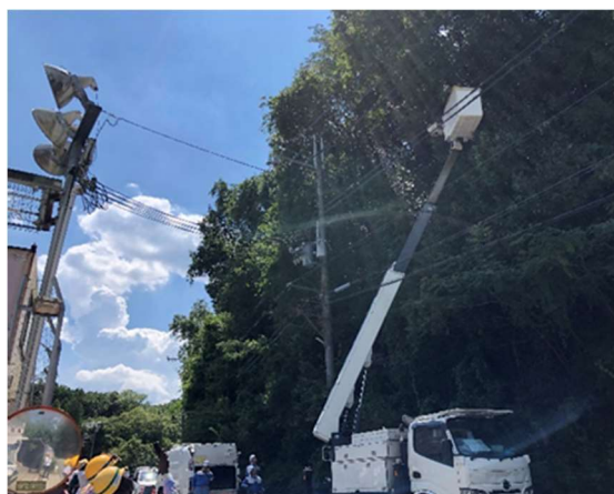
7/27 樹木伐採作業現場の見学
