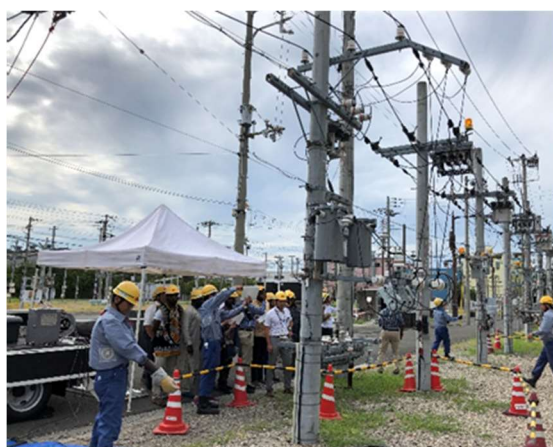
7/31PM 架空配電線研修設備の視察
