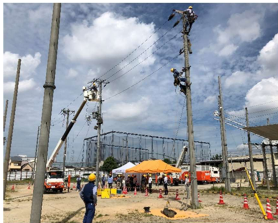
7/31AM 電線張替訓練視察
