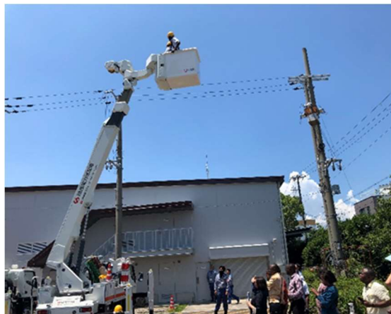
7/27 高所作業車(実機)の見学とデモ操作
