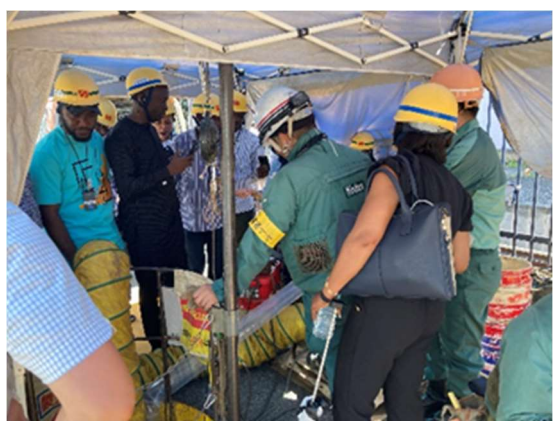
8/1AM 地中線工事現場の視察
