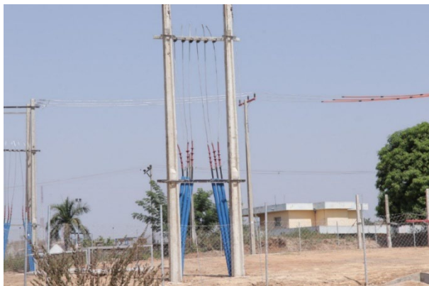
図 2-1-2.3 架空配電線と地中配電線
