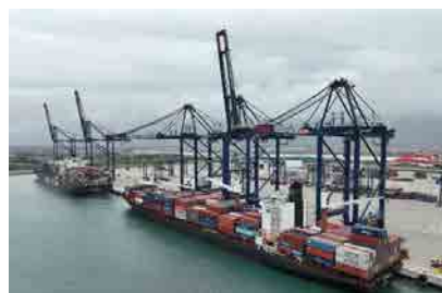
岸壁利用中のコンテナ船
