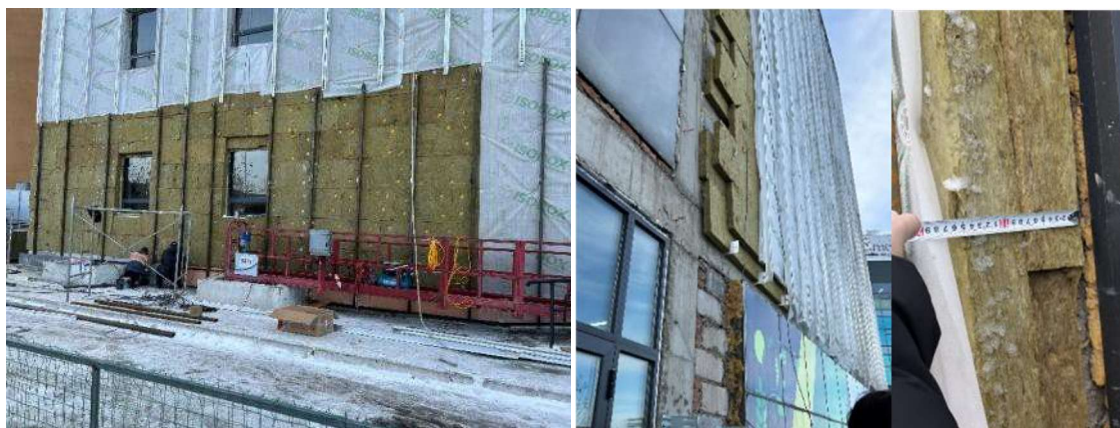
Figure 3-25 Барилгын дулаалгыг шалгах (Оффисын барилга)
