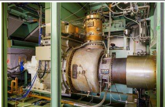
Figure 5-38 Аммиакийн хийн турбин (IM270)
