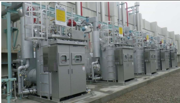
Figure 5-34 Устөрөгчийн бойлер суурилуулсан химийн үйлдвэр
