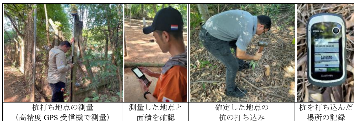
図 3-2：事業サイトの図面に基づく境界杭打ち
