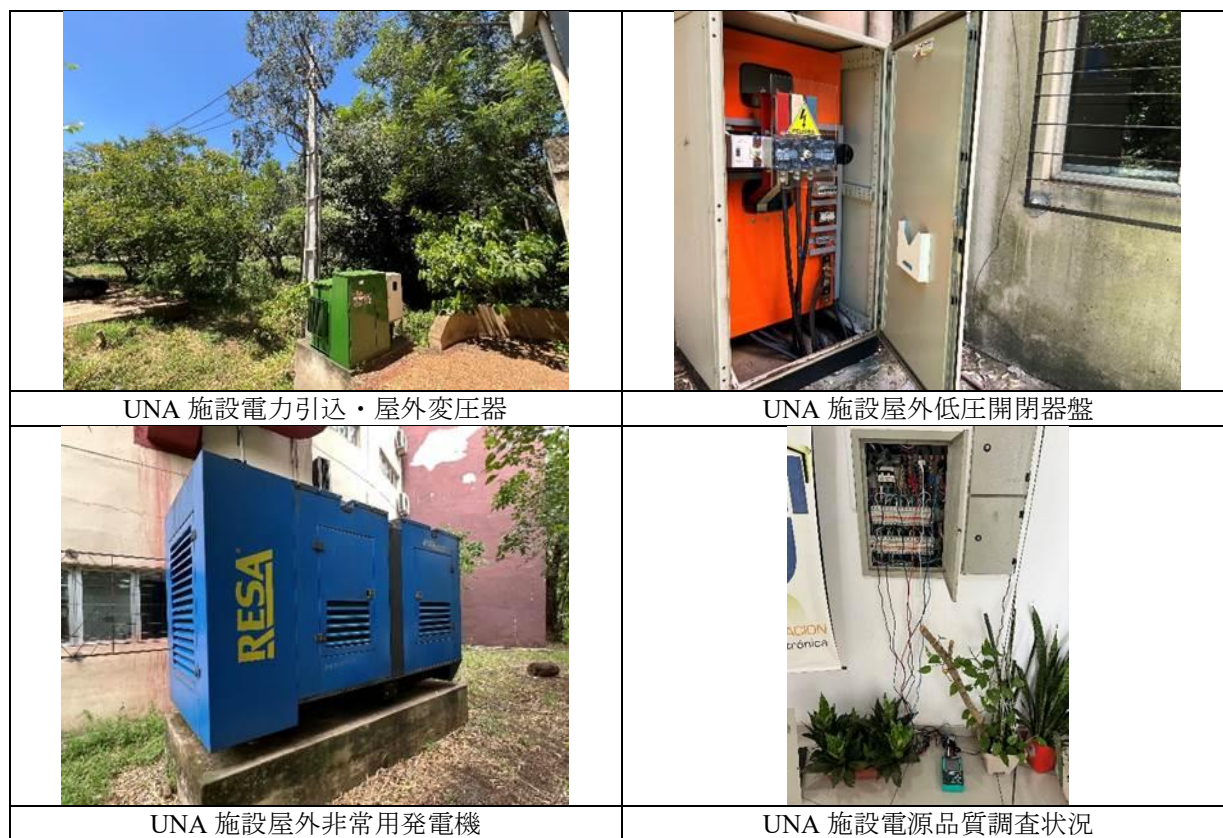
図 2-6：電力引込、屋外発電機写真
