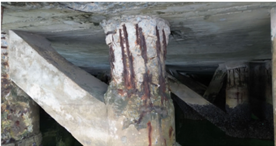
図 1-34 南埠頭の岸壁構造における老朽化の進展状況
