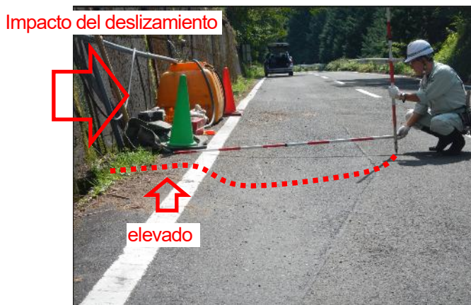
Suelo del cimiento elevado
