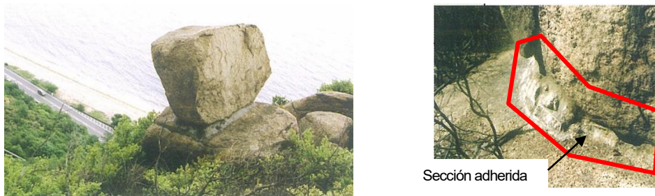
Figura 72 Ejemplo de Obras de Adhesión en Japón
