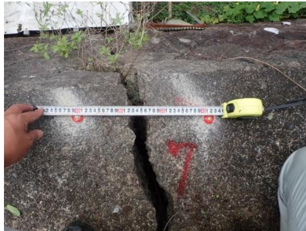
Figura 30 Monitoreo de grietas (medición de marcas o remaches)
