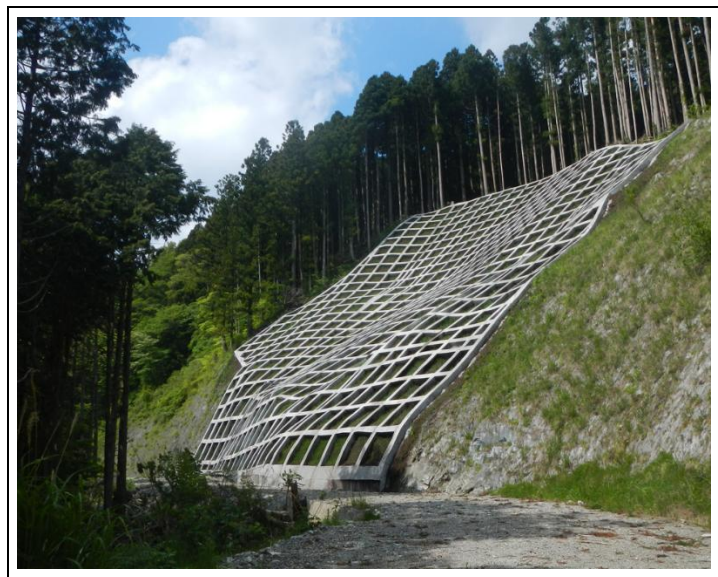
Figura 38 Caso de obra de cribado
