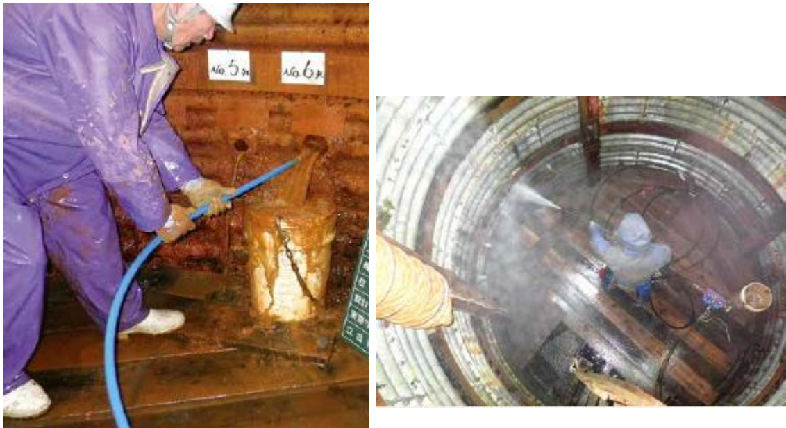
Figura 39 Proceso de limpieza (Caso de perforación horizontal de drenaje en pozo)
