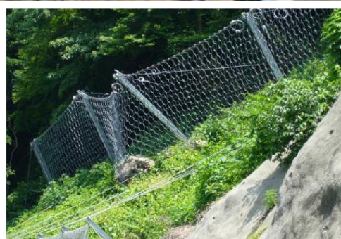
Figura 80 Ejemplo de Barrera Dinámica con Alta Absorción para Protección contra Caída de Rocas en Japón
