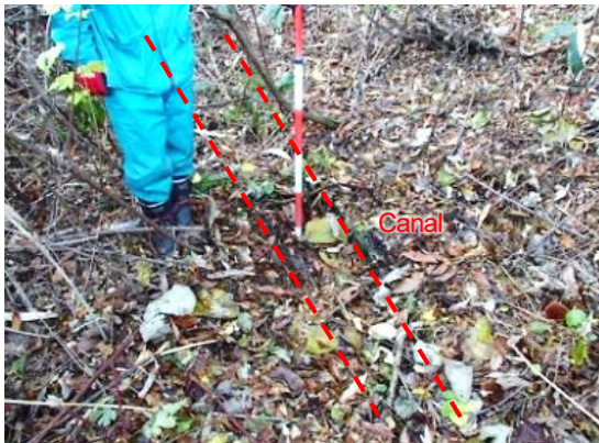
Obstrucción y soterramiento por sedimentos
