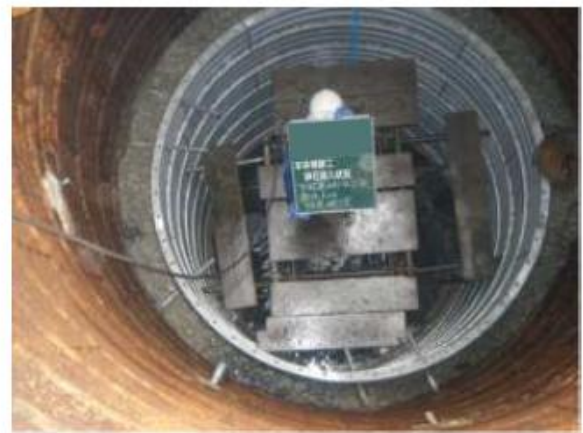
Extensión la tubería de drenaje horizontal
