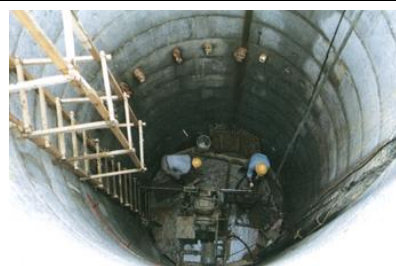
Pozo de drenaje de concreto armado
