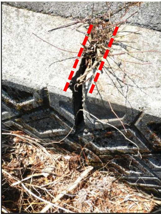
Muro de retención movido entre las uniones por la actividad del deslizamiento
