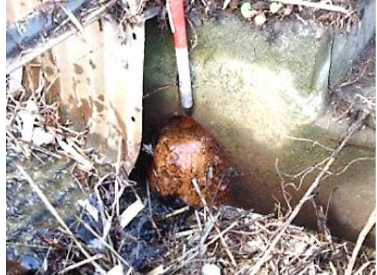
Obstrucción de la salida de la tubería de drenaje debido al lodo
