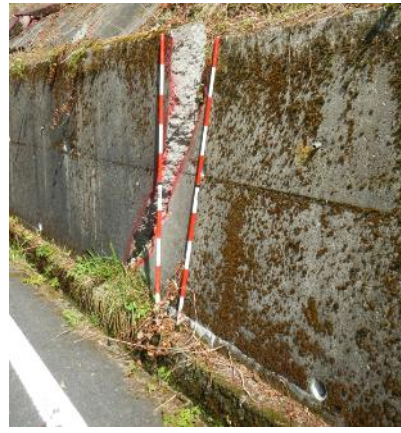
Muro de contención roto e inclinado por deslizamiento de tierras.
