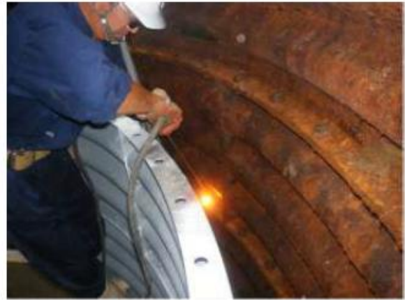
Instalación la placa de revestimiento interior
