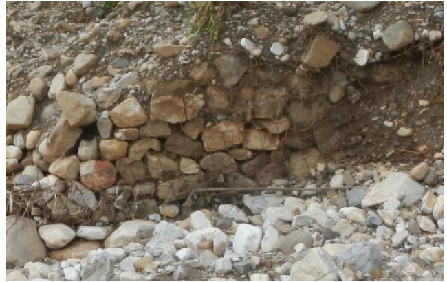
Gaviones colapsados
