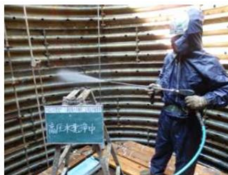
Limpieza de superficie del material de pozo
