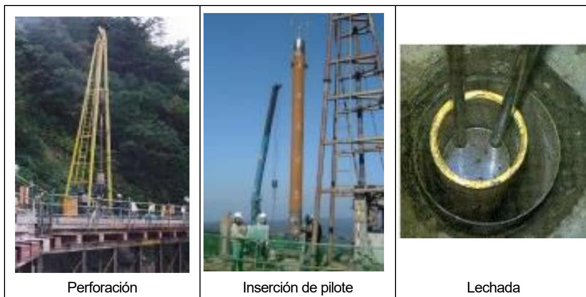
Figura 29 Proceso constructivo para pilotes
