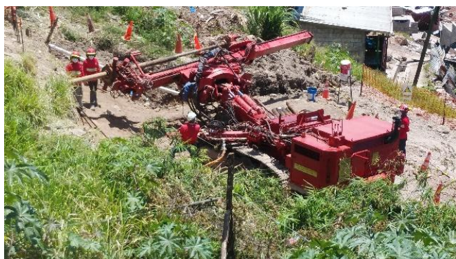
Proceso de Perforación
