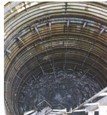
Interior del pozo de
