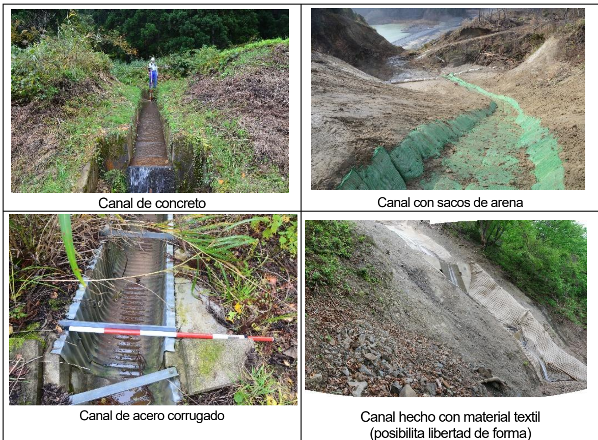
Figura 5 Fotos de casos de canalizaciones (en Japón)
