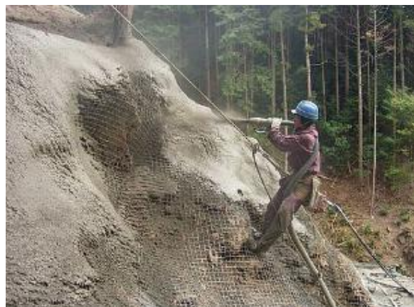
Figura 23 Imagen del esquema y fotografía de caso de estudio del shotcrete
