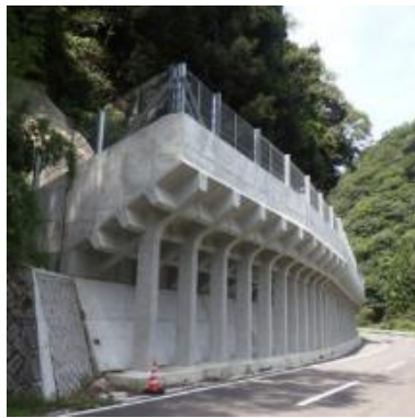
Figura 83 Ejemplo de Estantes de Protección contra Caída de Rocas en Japón
