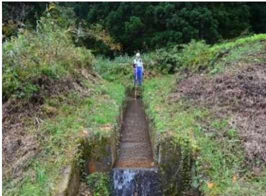
Obras de control de aguas superficiales (canales)
