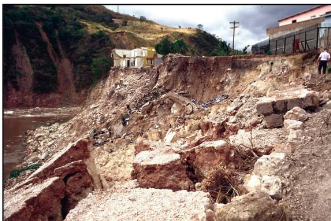
Figura 4 Deslizamientos de tierra en el Barrio Miramesi, adyacente al Río Choluteca (AMDC)
