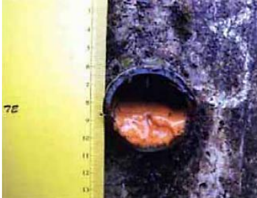
Obstrucción de la salida de la tubería de drenaje debido al lodo
