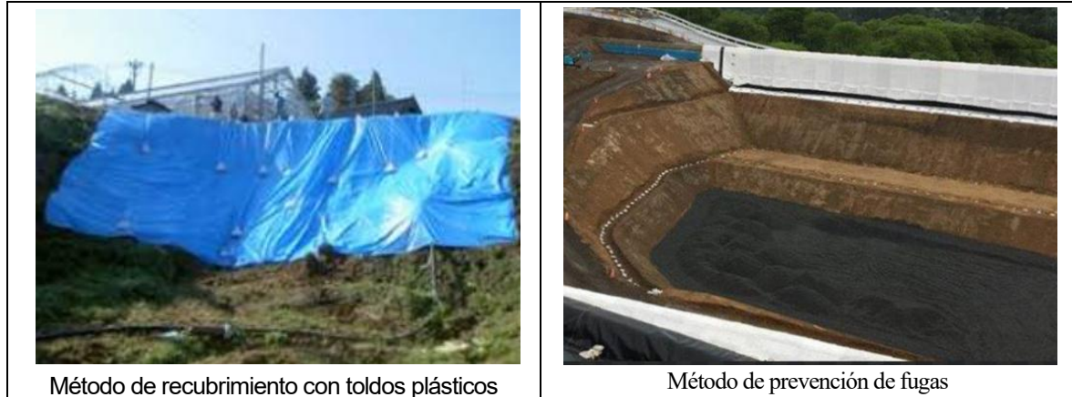
Figura 6 Casos de aplicación de métodos para prevención de infiltración (en Japón)
