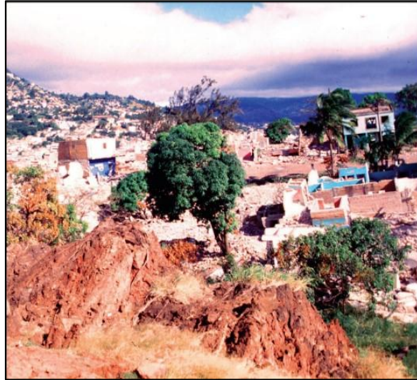
Figura 2 Vista de la ya muy deformada área del pie del deslizamiento de tierra El Berrinche (AMDC)
