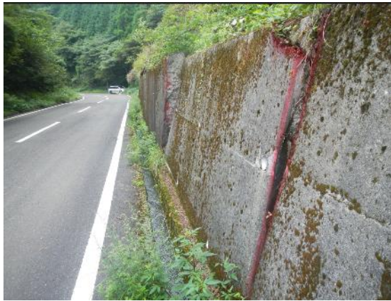
Muro de contención roto e inclinado por deslizamiento de tierras.
