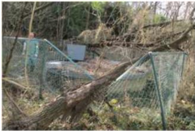
Deformación de la cerca de seguridad
