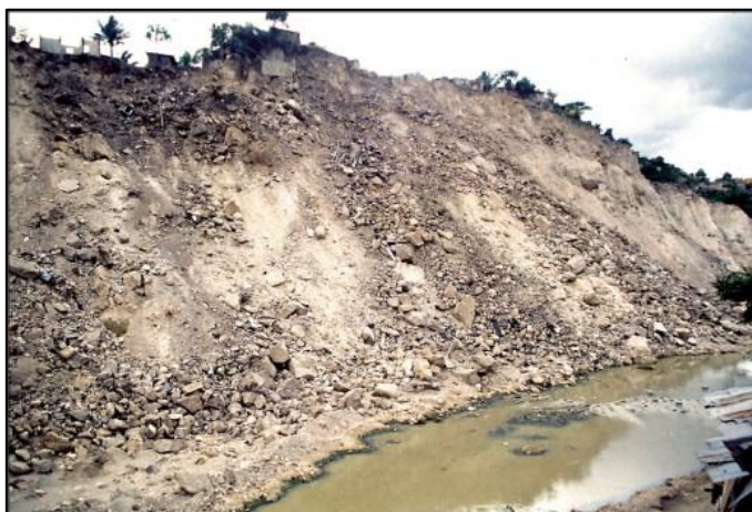
Figura 5 Deslizamiento de tierra a lo largo del Río Guacerique (AMDC)
