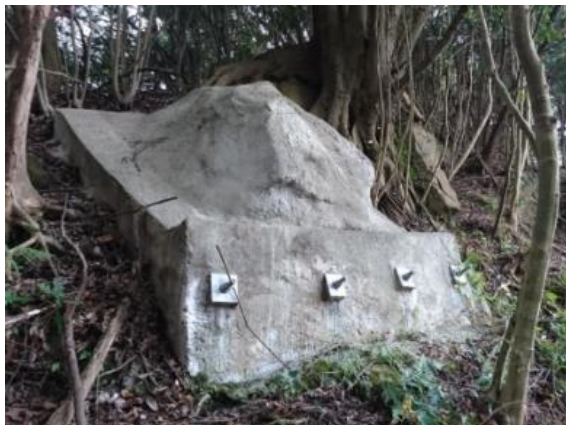
Figura 75 Ejemplo de Obra de Protección en el Pie en Japón
