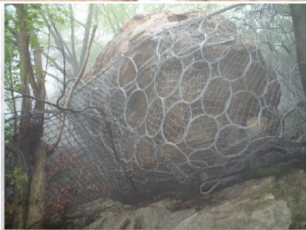
Figura 80 Ejemplo de Barrera Dinámica con Alta Absorción para Protección contra Caída de Rocas en Japón
