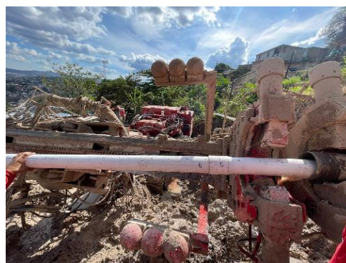
Instalación de Tubería de Drenaje
