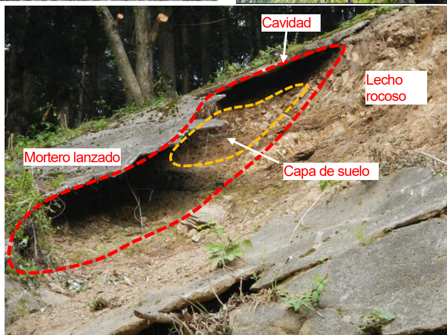
Figura 27 Imagen del esquema y fotografía de caso de estudio de escorrentía de suelo bajo el shotcrete
