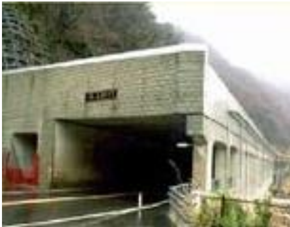
Figura 82 Ejemplo de Cobertizo para Caída de Rocas en Japón
