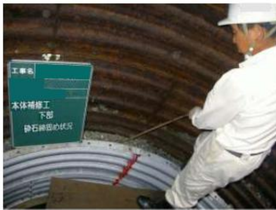
Relleno con grava detrás nueva placa interior
