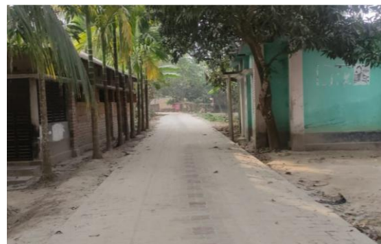
LGED によるユニブロック舗装施工事例 (LGED Rajshahi Office)
