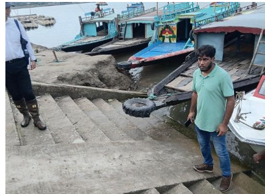
既設船着き場 （RC 構造、幅員約 5.0m）
