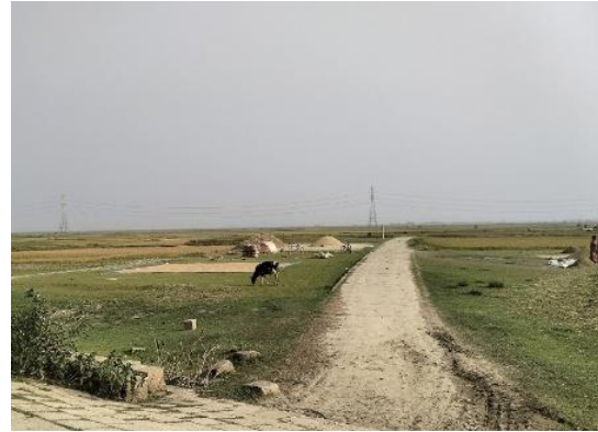
村落道路（潜水） 非潜水時状況 （鉄筋コンクリート舗装、フェーズ1で工事 実施された道路）
