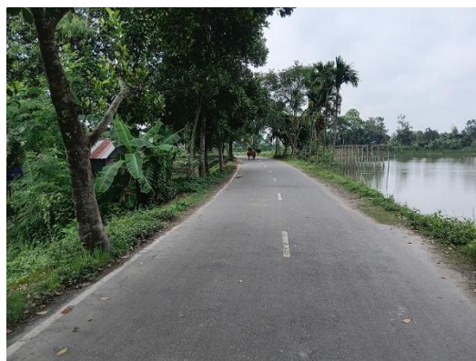
舗装済みウパジラ道路（非潜水） （アスファルト舗装、幅員:5.5m）
