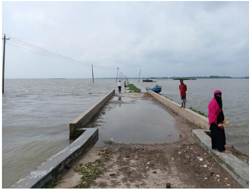
ユニオン道路（潜水） 潜水時状況 （鉄筋コンクリート舗装、幅員:3.0m）
