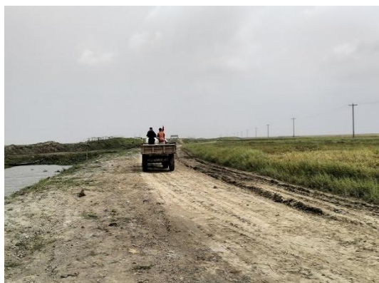
未舗装道路の状況
