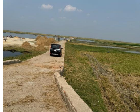
ユニオン道路（潜水） 非潜水時状況 （鉄筋コンクリート舗装、幅員:3.0m）
