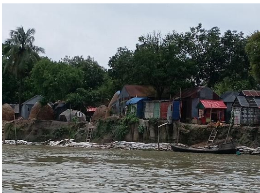
村民自身の手による村落保護工 (土のうと植生による防御)
