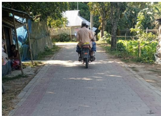
LGED によるユニブロック舗装施工事例 (LGED Mymensingh Office)
