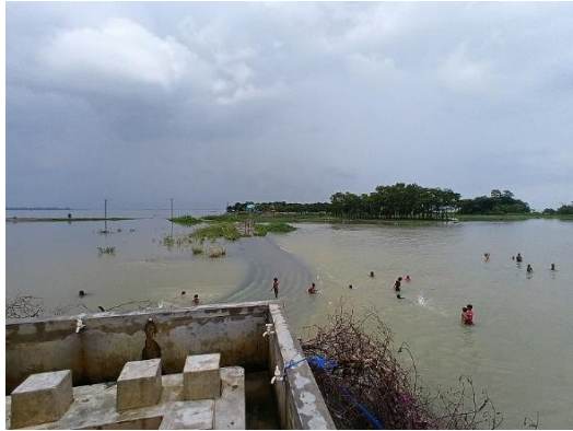
村落道路（潜水） 潜水時状況 （鉄筋コンクリート舗装）
