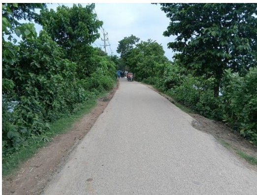
舗装済ユニオン道路（非潜水）状況 （アスファルト舗装）
