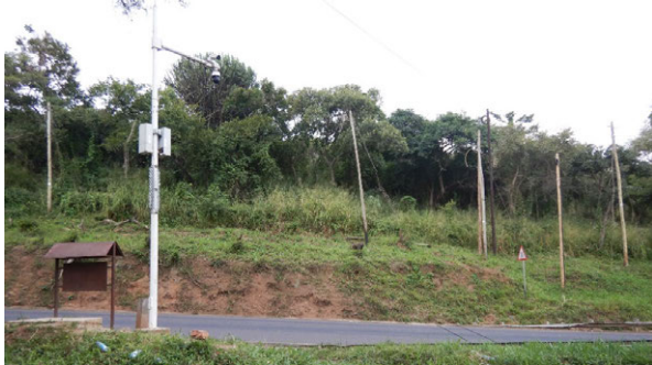
電線や電柱、CCTV カメラ
