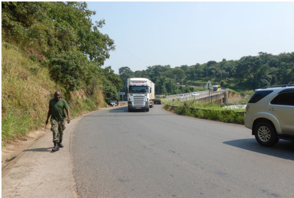
左岸側の取付道路
