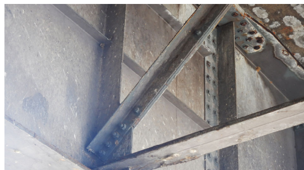
主桁や横桁に断面欠損やボルト欠如等大きな損傷はない
