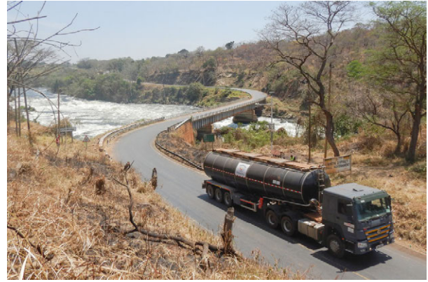
現カルマ橋全景（右岸側より撮影）
