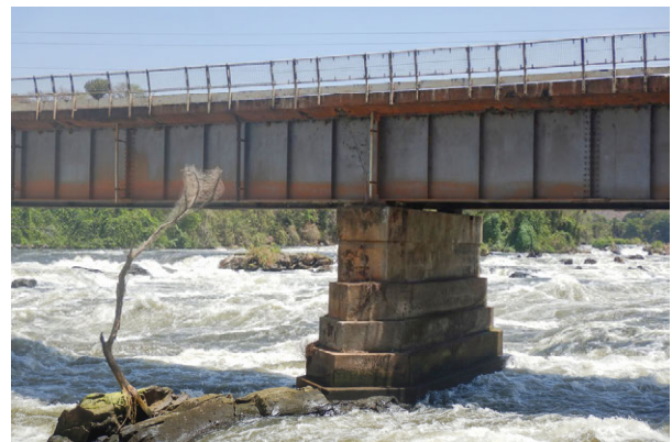
左岸側の橋脚
