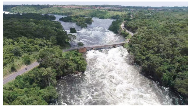
現カルマ橋の下流側より撮影
