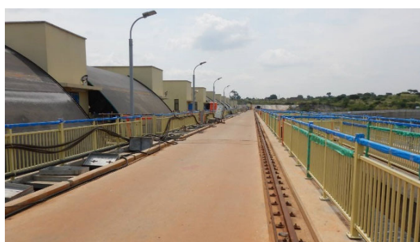
ダム管理用通路
