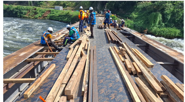
床版取替工事の状況
