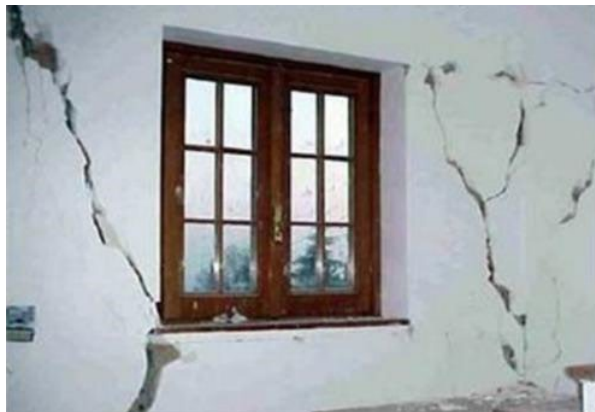
図 2.1.6 家屋の被害例(基礎のクラック)
