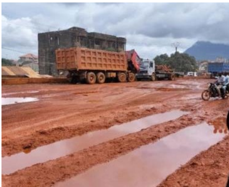
図 2.4.1 未舗装のラテライト道路の変状 (ギニア)
