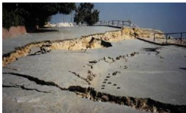
図 2.3.4 黄土の沈下とガリ侵食
