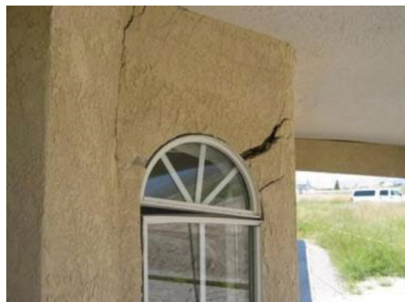
図 2.3.9 崩壊性石膏土地盤の建物のクラック
