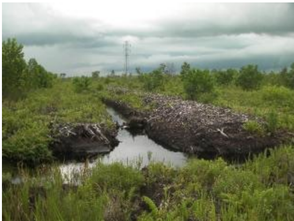
図 3.8.1 対策された構造物の泥炭地盤の沈下による引き込まれ変状
