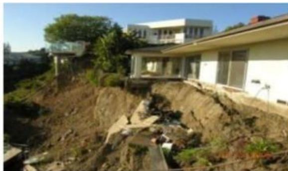
図 2.3.3 崩壊性石膏土の崩壊
