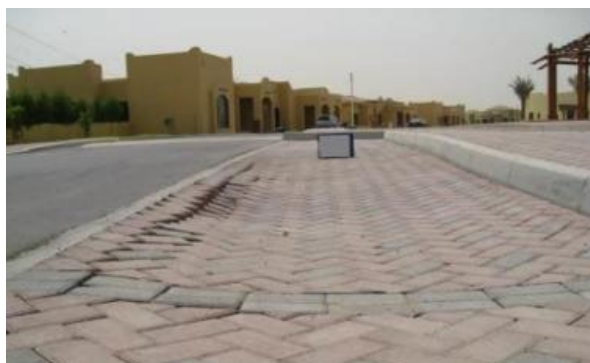
図 2.3.5 崩壊性石膏土の崩壊
