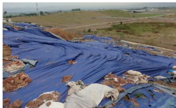
図 2.1.19 盛土斜面の被害(インドネシア)
