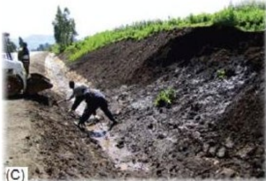
図 2.1.23 切り土斜面の崩壊
