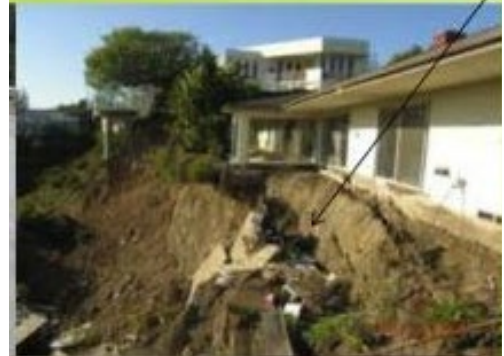
図 2.1.24 斜面の崩壊
