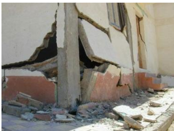
図 2.3.8 崩壊性土の家屋の被害(エジプト)
