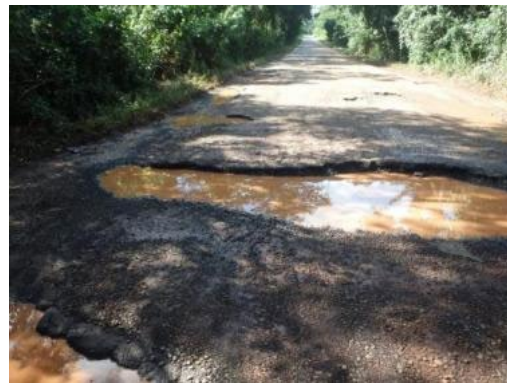
図 2.4.2 ギニア国国道1号線の道路被害
