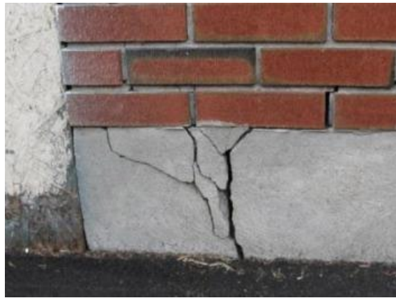
図 2.1.6 家屋の被害例(基礎のクラック)
