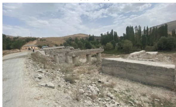
図 2.3.5 崩壊性石膏土の崩壊
