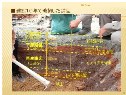
図 2.4.3 路盤の劣化に起因すると思われる舗装の損傷と解体調査の状況(ラオス)
