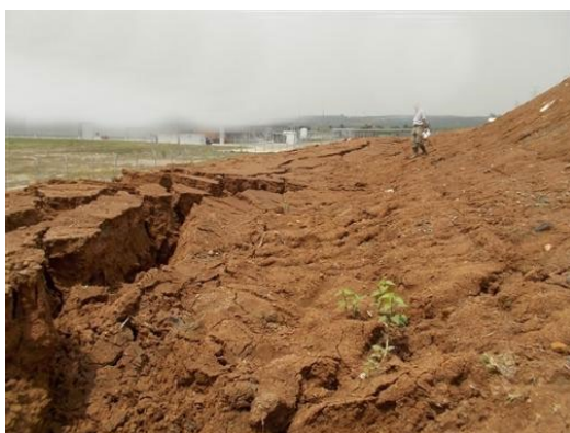
図 2.1.19 盛土斜面の被害(インドネシア)
