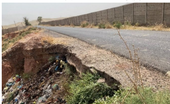
図 2.3.4 黄土の沈下とガリ侵食
