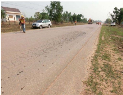
図 2.4.3 路盤の劣化に起因すると思われる舗装の損傷と解体調査の状況(ラオス)
