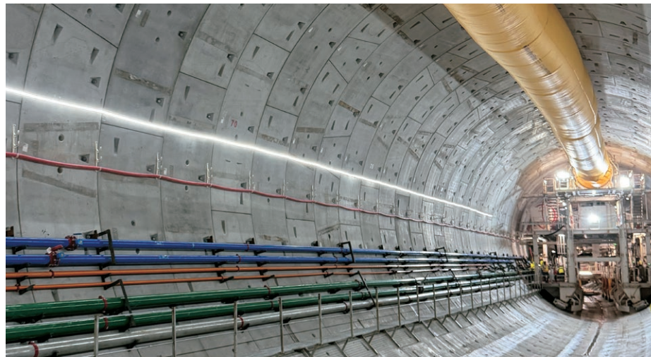
パナマで建設が進む地下鉄のシールドトンネル掘削現場
