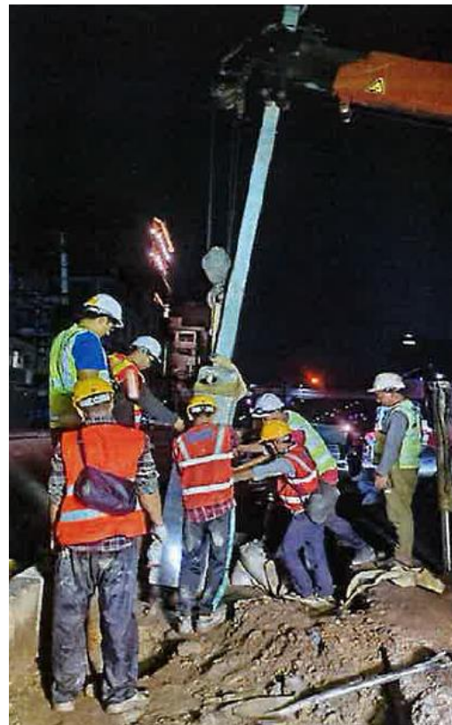
図 5.16：Naya Baneshwor 交差点工事(左：街灯移設、左：フラッグポール移設)
