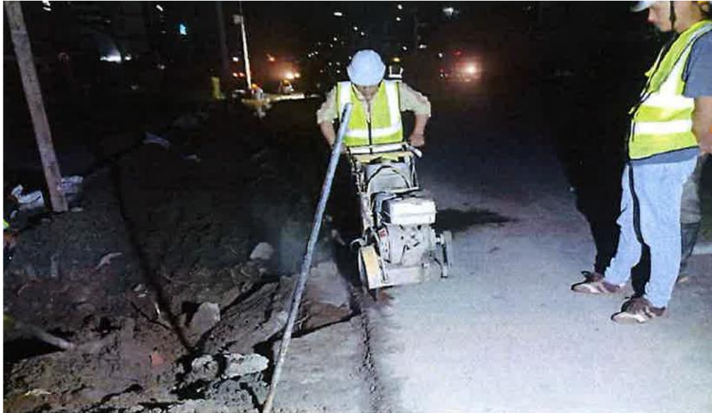
図 5.15：Naya Baneshwor 交差点工事(既設側溝の取り壊し)
