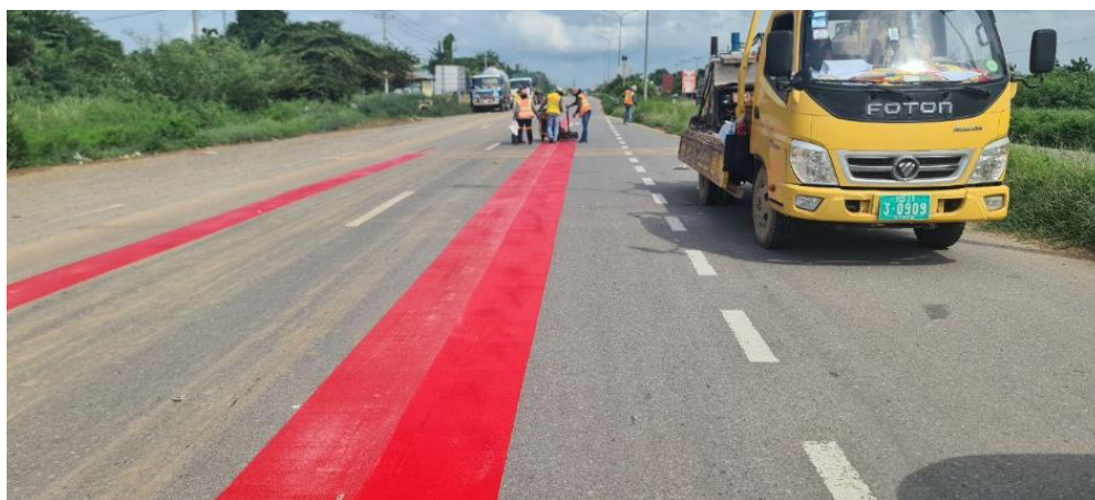
図 5.3.21 2022 年度パイロットプロジェクトの実施状況(⑤Colored Road Markings)
