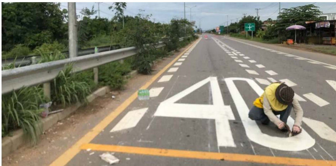
図 5.3.20 2022 年度パイロットプロジェクトの実施状況(②40km/h-Markings)
