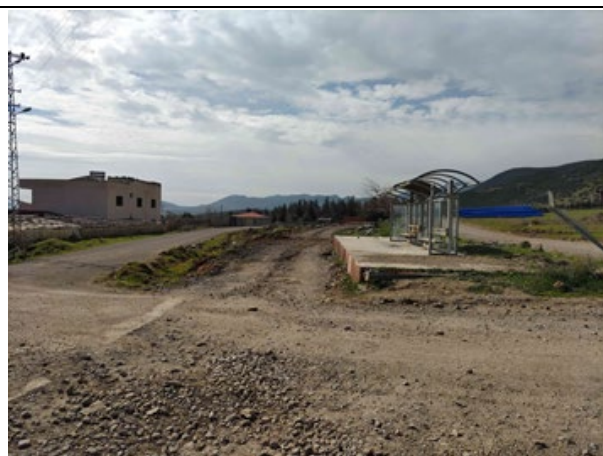
図 6-22 3 km区間の軌道撤去状況
