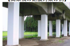
鋼板巻きによる高架橋の耐震補強
