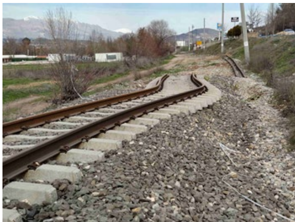
図 6-10 ギョルバシュ駅付近の大きく変形した軌道
