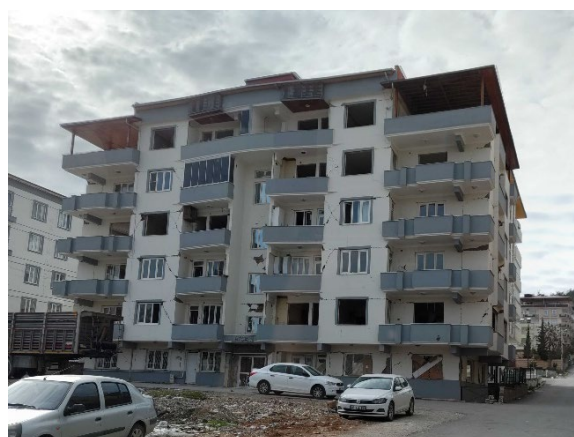
図 6-8 地震によるひび割れの残る建物
