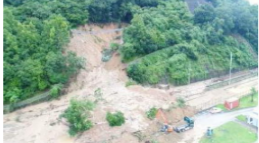
JR西日本 呉線の被災状況 (平成30年7月豪雨)
