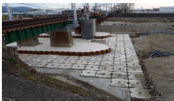
ブロックによる橋脚の補強
