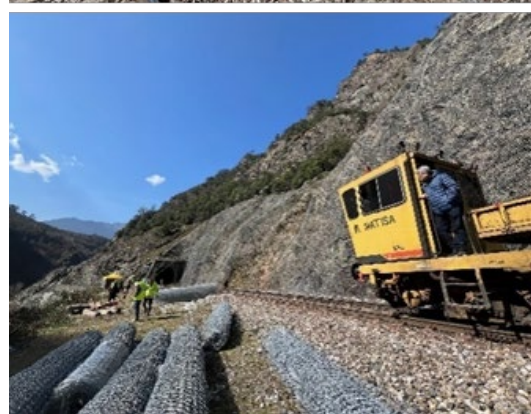
図 2-9 TCDD による落石防護工設置
