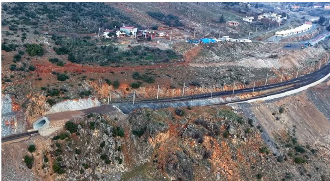
図 6-31 フェヴジパシャ構内の地すべり対策の擁壁
