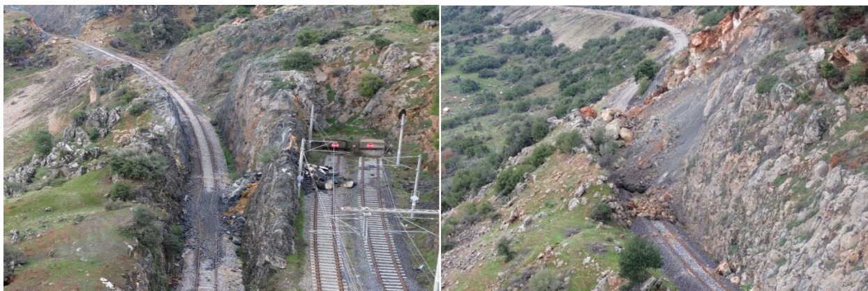
図 6-3 フェヴジパシャ駅付近における落石・崩落による被害
