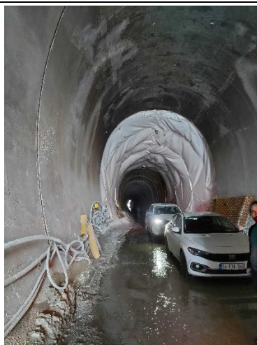
図 6-14 NATM 区間と開削区間接続部（手前が NATM）
