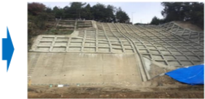
コンクリート枠による斜面の補強
