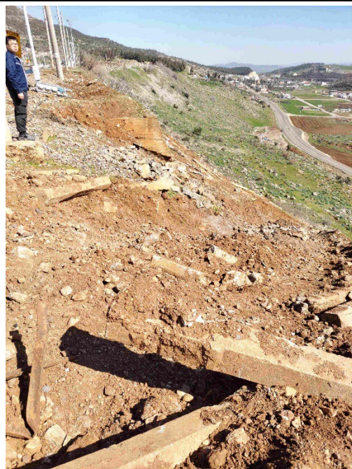
図 6-28 路盤の崩壊
