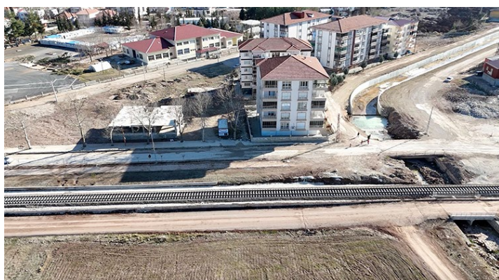
図 6-11 ギョルバシュ駅マラティア方の路盤の復旧状況
