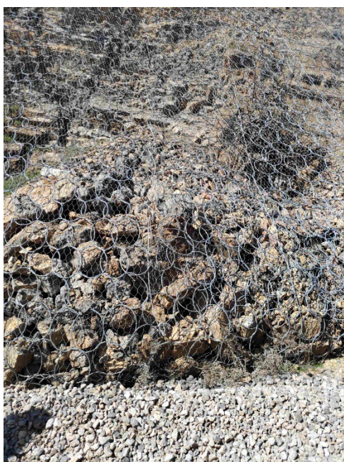
図 6-25 落石防護網と落石
