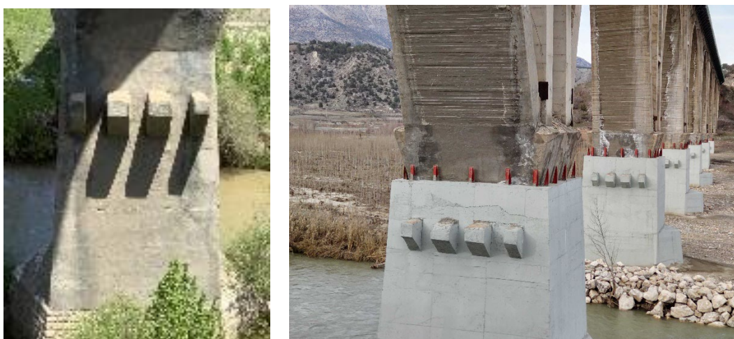
図 6-18 C 橋脚の外観（左：復旧前、右：復旧後）
