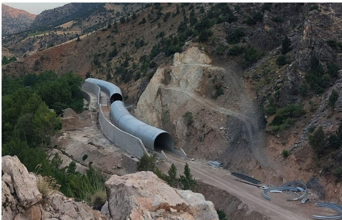
図 6-46 施工中のコルゲートトンネル
