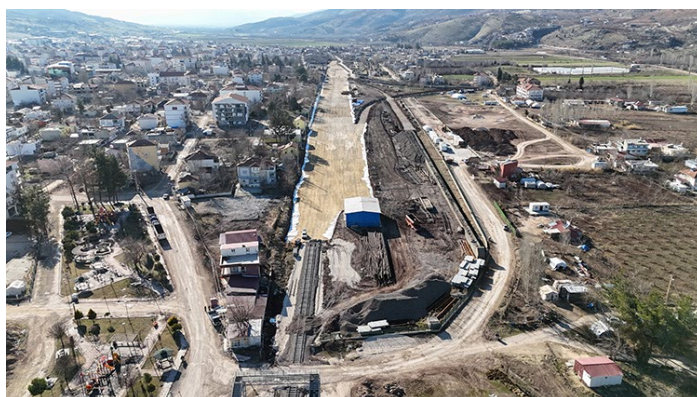
図 6-12 ギョルバシュ駅中心付近の路床置換えとみられる様子
