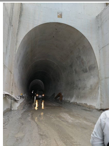
図 6-15 終点方開削トンネル坑口
