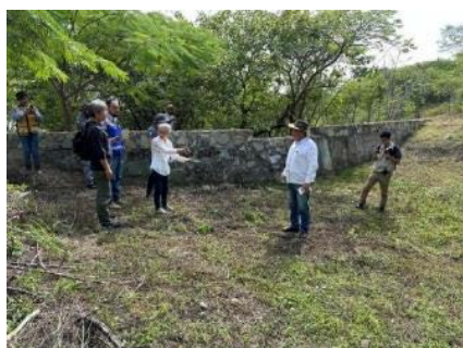
Dique construido por los residentes de Club Campestre con sus propios medios y fondos para almacenar temporalmente el agua de las inundaciones
