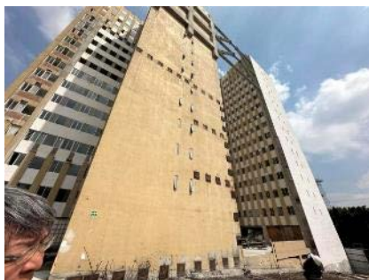
Refuerzo sísmico en el edificio Tlalpan 550 (330 viviendas), afectado por el terremoto del 19 de septiembre de 2017. El Ayuntamiento de la Ciudad de México ha aportado 330 millones de pesos (2770 millones de yenes). La ejecución duró tres años. También se construyeron vigas para unir los dos bloques de edificio.
