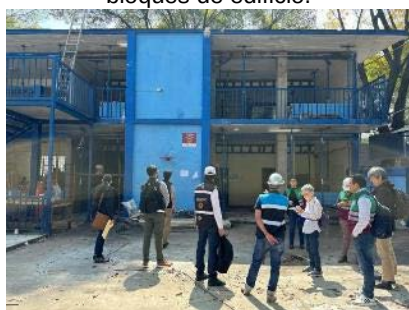
Refuerzo sísmico de la escuela primaria Maestro Francisco César Morales, afectada por el terremoto del 19 de septiembre de 2017. El Ayuntamiento de la Ciudad de México ha aportado 6 millones de pesos (50 millones de yenes). Las obras se llevarán a cabo en un plazo de seis meses.
