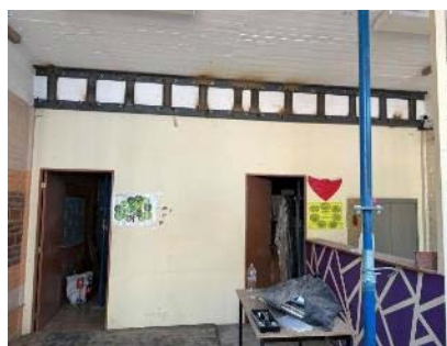
Refuerzo sísmico en el interior de las aulas de la escuela primaria. Se prevé reforzar las columnas y las vigas para mejorar la resistencia sísmica.
