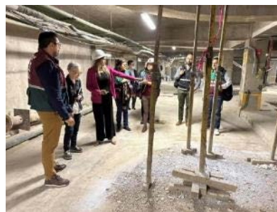
Obras en el interior del edificio Tlalpan 550. Se prevé reforzar los pilotes y las paredes para mejorar la resistencia sísmica.
