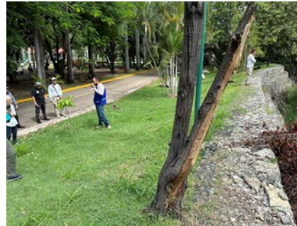
洪水時には氾濫した洪水を貯留して遊水機能を発揮するサビナル川沿いの公園
