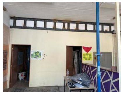
同小学校の教室内の耐震補強工事現場。柱と梁を
