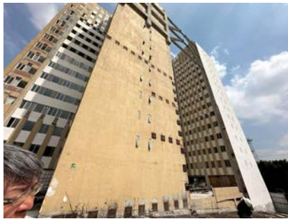
2017 年 9 月 19 日の地震で被災した Tlalpan 550 アパート（330 世帯）の耐震工事現場。メキシコ市が 3 億 3 千万ペソ（27 億 7 千万円）の資金を拠出し 3 年間の工期で施工中。アパートの棟と棟を連結する梁も施工した。
