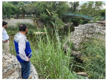
サビナル川本川と支川の合流点（サビナル川本川より支川の方が洪水被害が大きい。）
