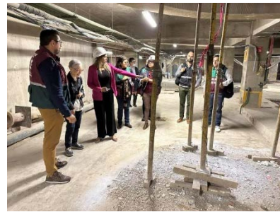
Tlalpan 550 アパート内部の施工現場。杭や壁を増強して耐震性能を向上させる予定。
