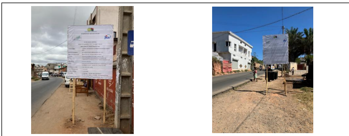
Figure 2-57 Panneaux des travaux en place (début et fin de chantier)
