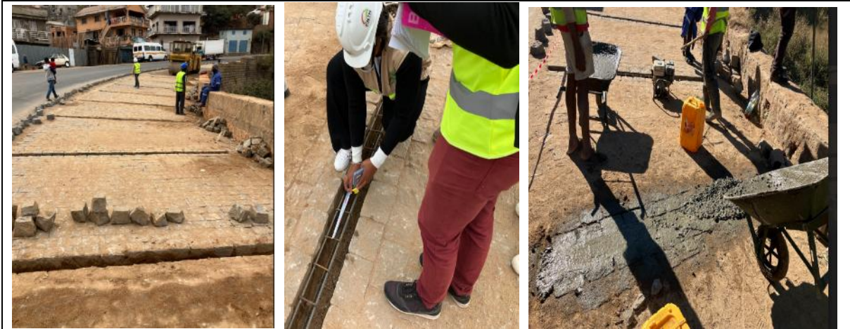
Figure 2-53 Mise en œuvre du béton dans les travaux d'accotement (espacement de 3 mètres) (travaux en cours)
