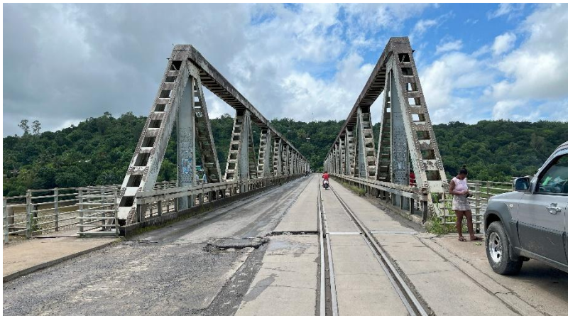
Photo 3 Pont métallique (pont en treillis)
