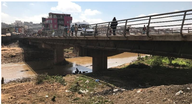
Photo 1 Pont où le lit majeur existe au-dessous de ses poutres
