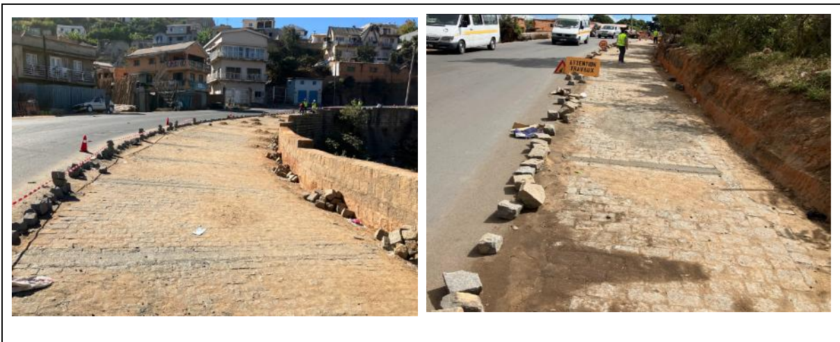
Figure 2-54 Mise en œuvre du béton dans les travaux d'accotement (espacement de 3 mètres) (après l'achèvement)
