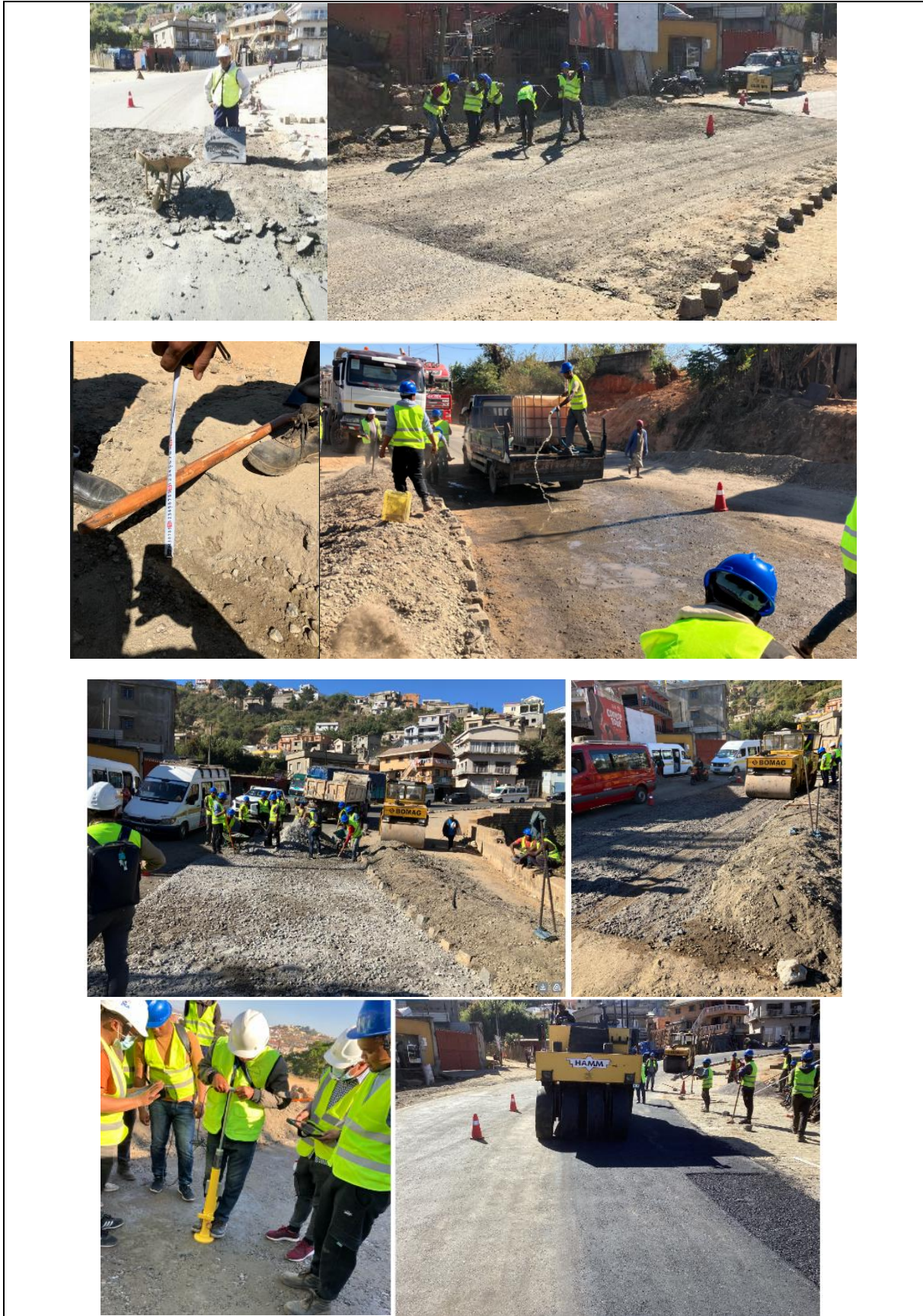
Figure 2-55 Remplacement des chaussées (réparation des couches de roulement (bicouche))
