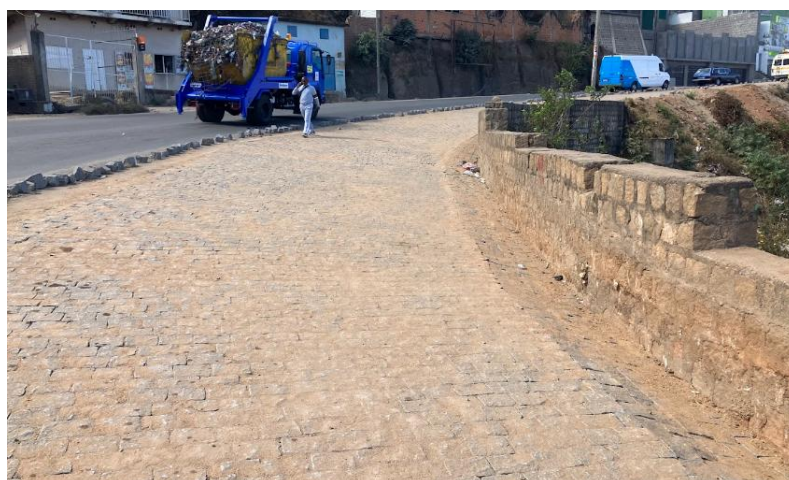
Pavés autobloquants au niveau de l'accotement (travaux achevés)
