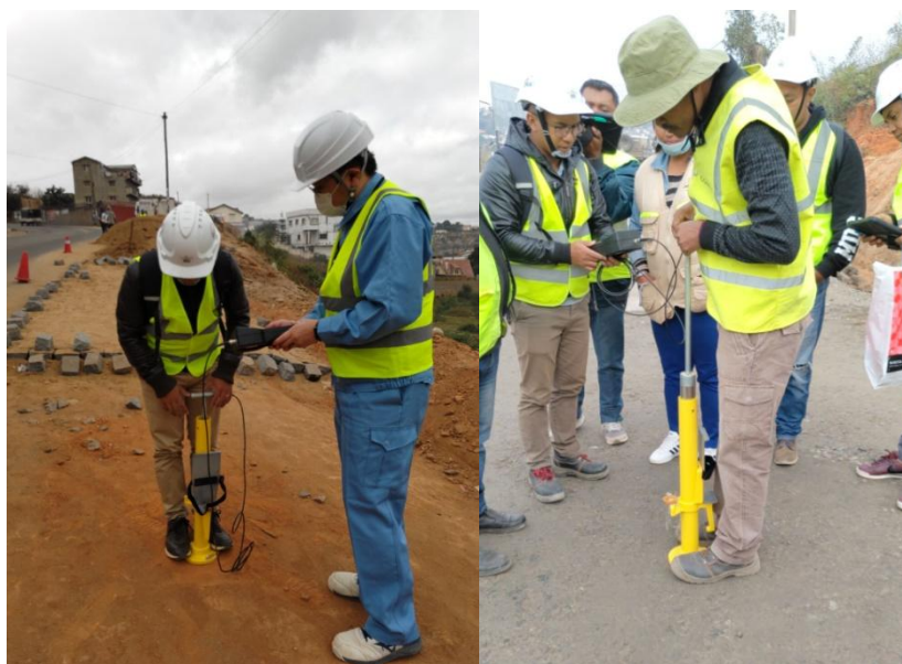
Mesure du CBR de la couche de forme sous les pavés autobloquants (à gauche) / Mesure du CBR de la couche d'assise (à droite)
