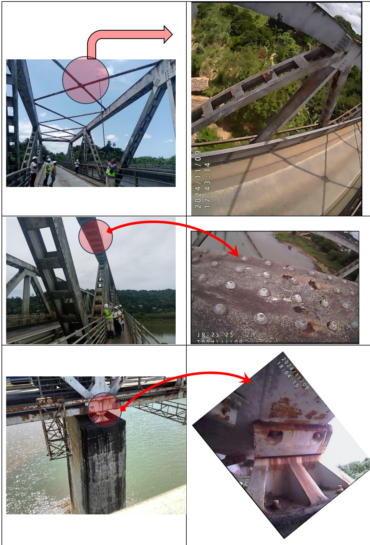
Figure 2-84 Situation de la formation sur le tas utilisant la perche à caméra
