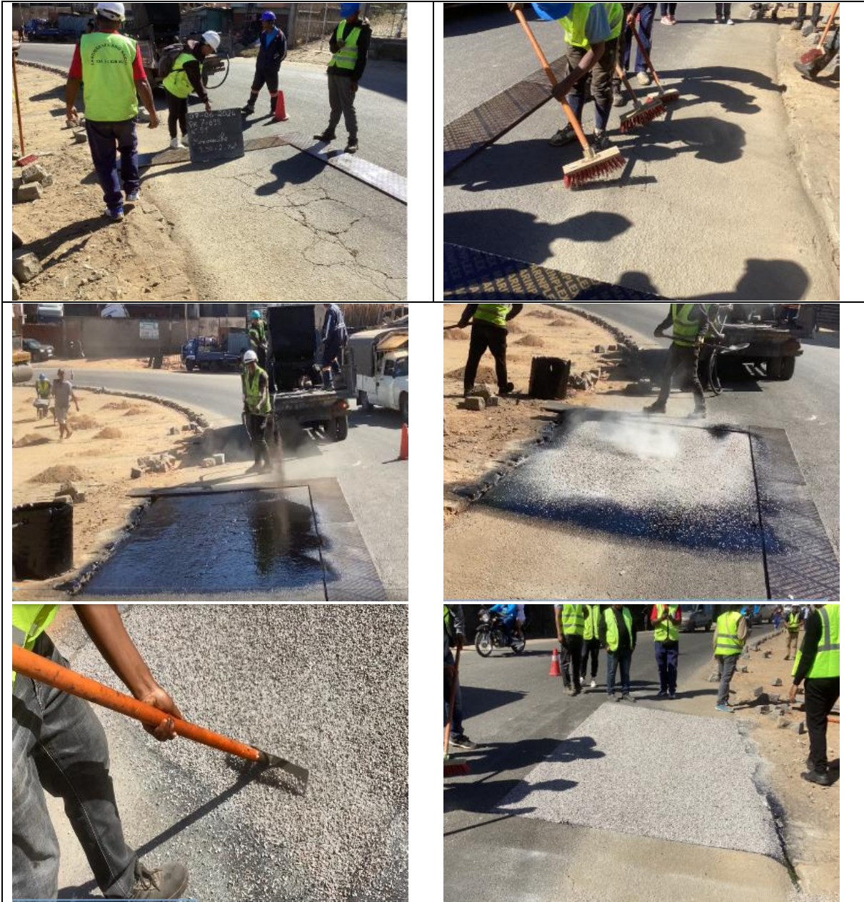
Figure 2-51 Travaux de traitement de surfaces exécutés (juste après l'exécution)
