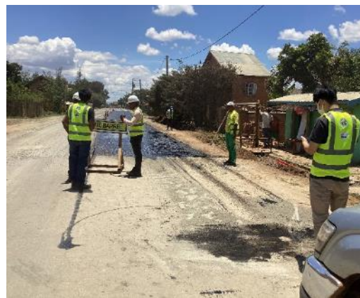
Visite d'un chantier où des travaux de réparation sont en cours
