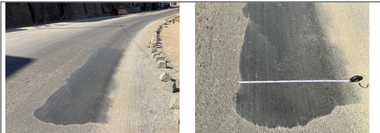
Figure 2-52 Travaux de traitement de surfaces (une semaine après les travaux)
