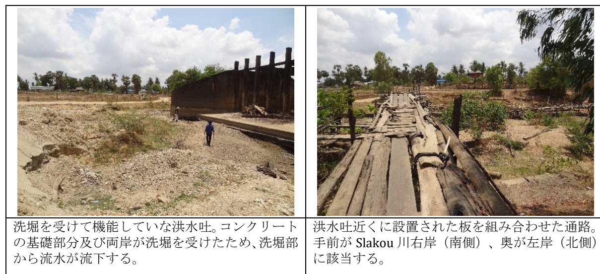
図 5.1.8 Tumnap Lok 灌漑地区 Slakou 川に設置された洪水吐付近の状況
