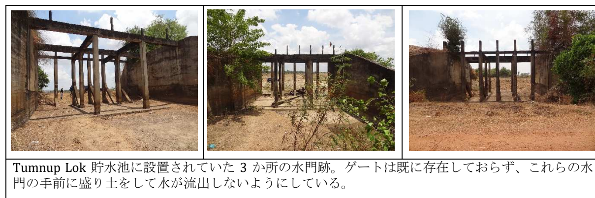
図 5.1.9 Tumnap Lok 灌漑地区 貯水池に直結する既存の水門の状況
