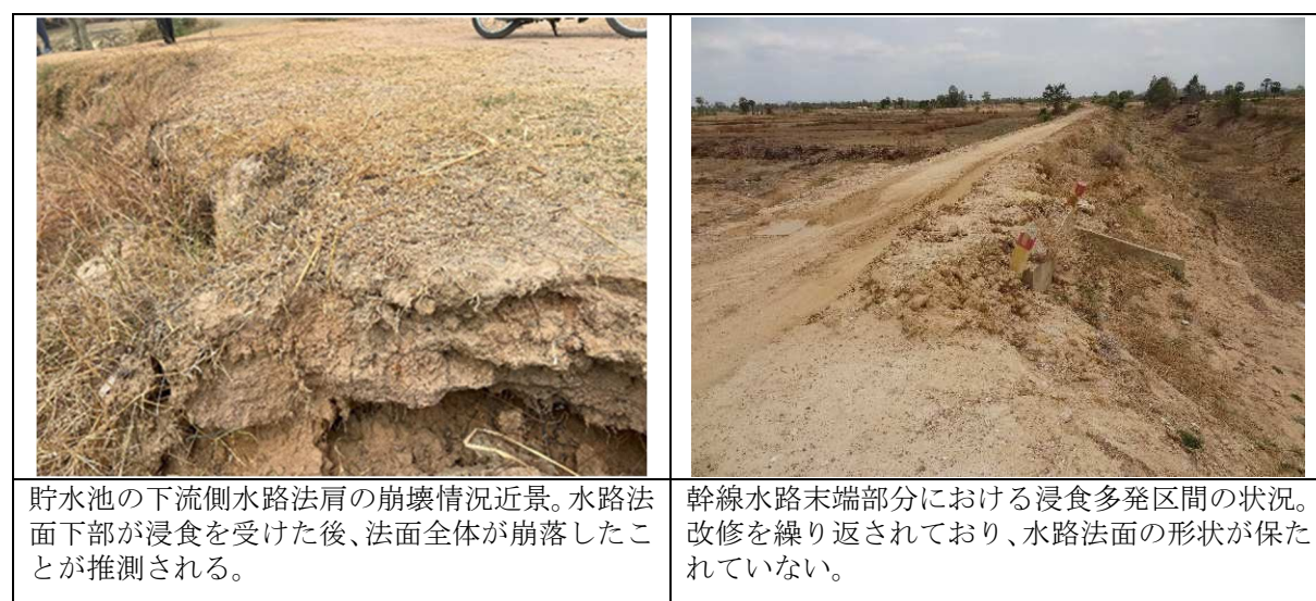
図 8.1.9 Khpob Krous 地区における幹線水路の浸食状況
