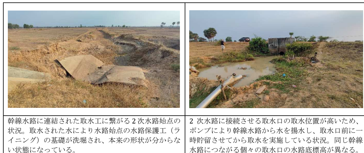
図 7.1.8 Plaing 地区貯水池の主要水利施設（取水口）
