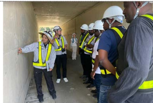
本州四国連絡高速道路(株) 鳴門管理センター クラック注入作業実演
