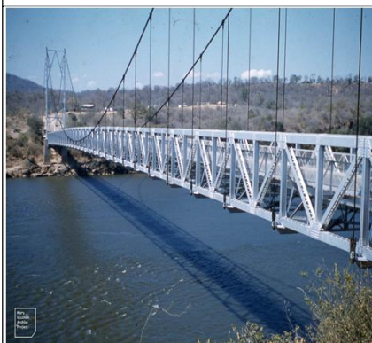
Decommissioned Otto Beit Bridge
