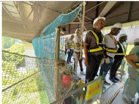
西日本高速道路(株) 高知高速道路事務所 柿ノ下橋視察
