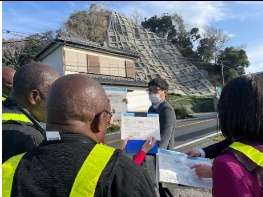
法面防災対策箇所視察（千葉国道事務所）
