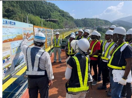
西日本高速道路(株) 愛媛工事事務所 上灘川橋視察
