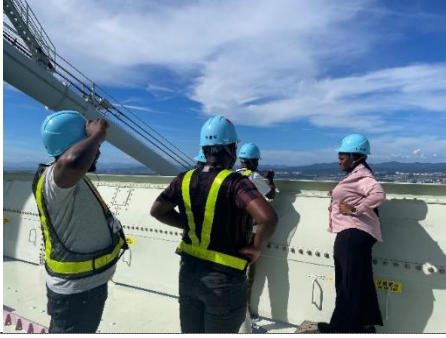
本州四国連絡高速道路(株) 神戸管理センター 明石海峡大橋 主塔上
