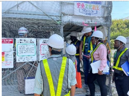
西日本高速道路(株) 高知高速道路事務所 笹ノ川橋視察
