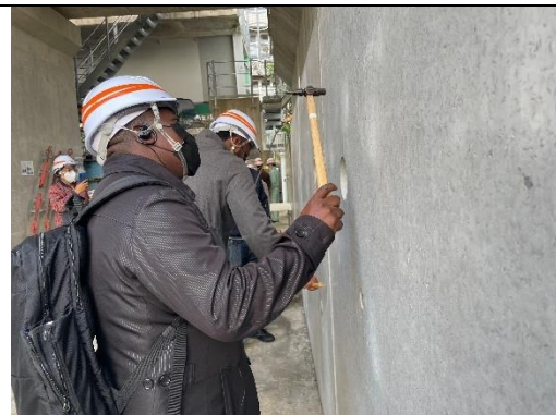
11/17 : NEXCO中日本 (N2U-BRIDGE) 非破壊点検実習
