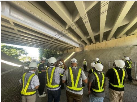
本州四国連絡高速道路(株) 鳴門管理センター 黒山橋 コンクリート補修現場
