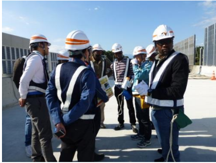
11/20 : NEXCO 中日本橋梁リニューアル工事現場視察
