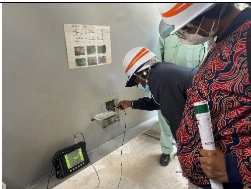
11/17 : NEXCO中日本 (N2U-BRIDGE) 非破壊点検実習
