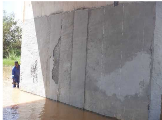
Ruena 橋モニタリング
