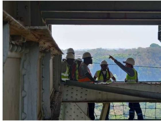
現場 OJT 状況
