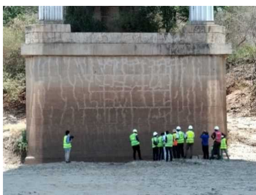
橋脚 II (Lusaka 側) の点検
