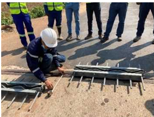
Rufunsa 橋での伸縮装置設置 OJT
