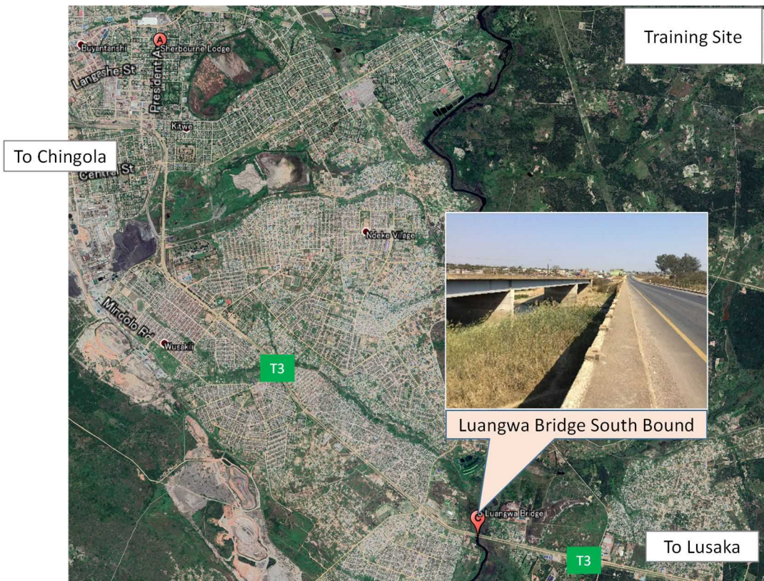
図 II-11 Copperbelt R0 における遠隔指導の対象橋梁 (Luangwa Bridge)
