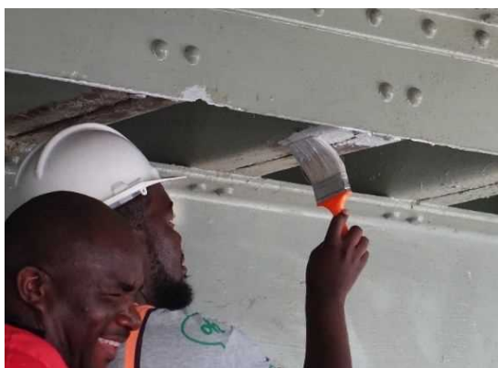
補修作業の現地研修(タッチアップペイント)
