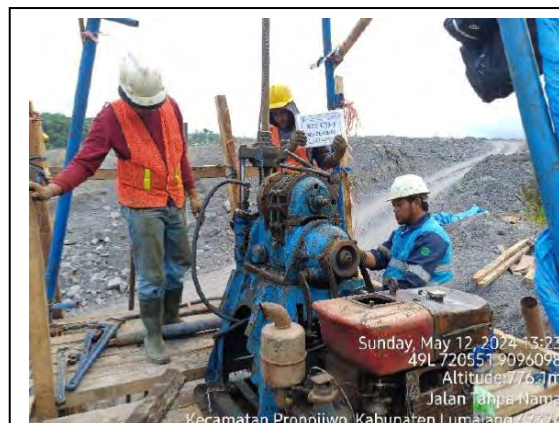
図 2-7 現地再委託業者による地質調査 2024.5.12 出典：JICA 調査団
