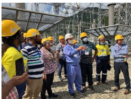
猪名川変電所視察
