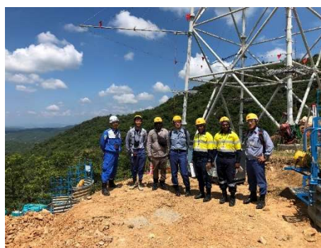
新加古川線改良工事視察
