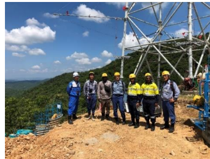
送電線工事現場視察
