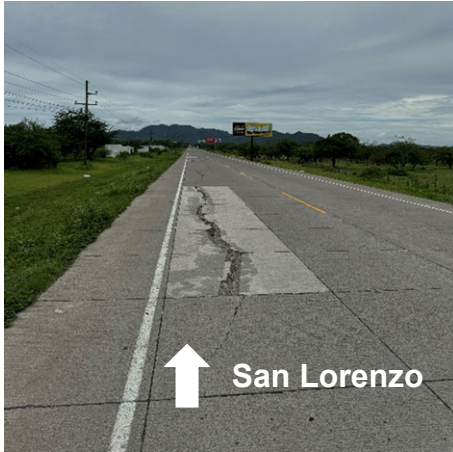
図 2.1.11 コンクリート舗装の損傷状況
