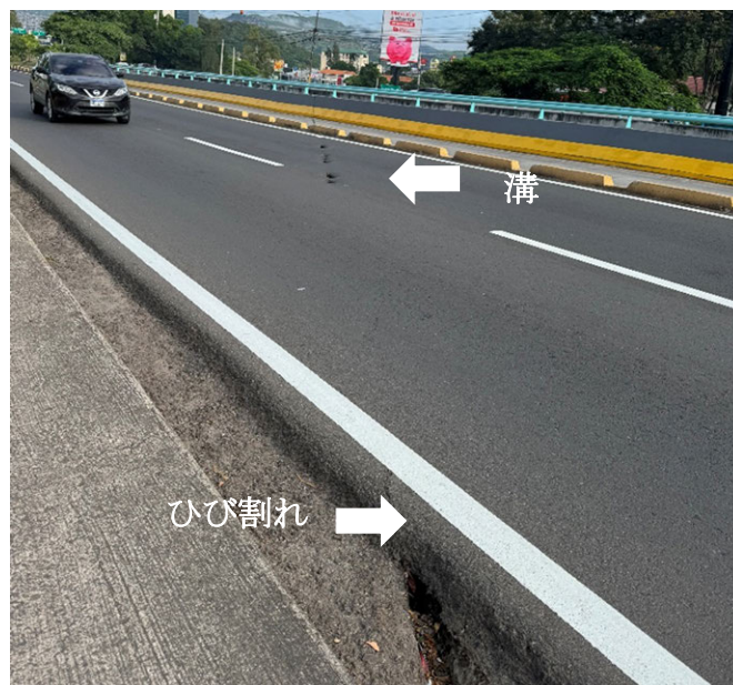
図 2.1.12 アスファルト舗装の施工状況（橋面）
