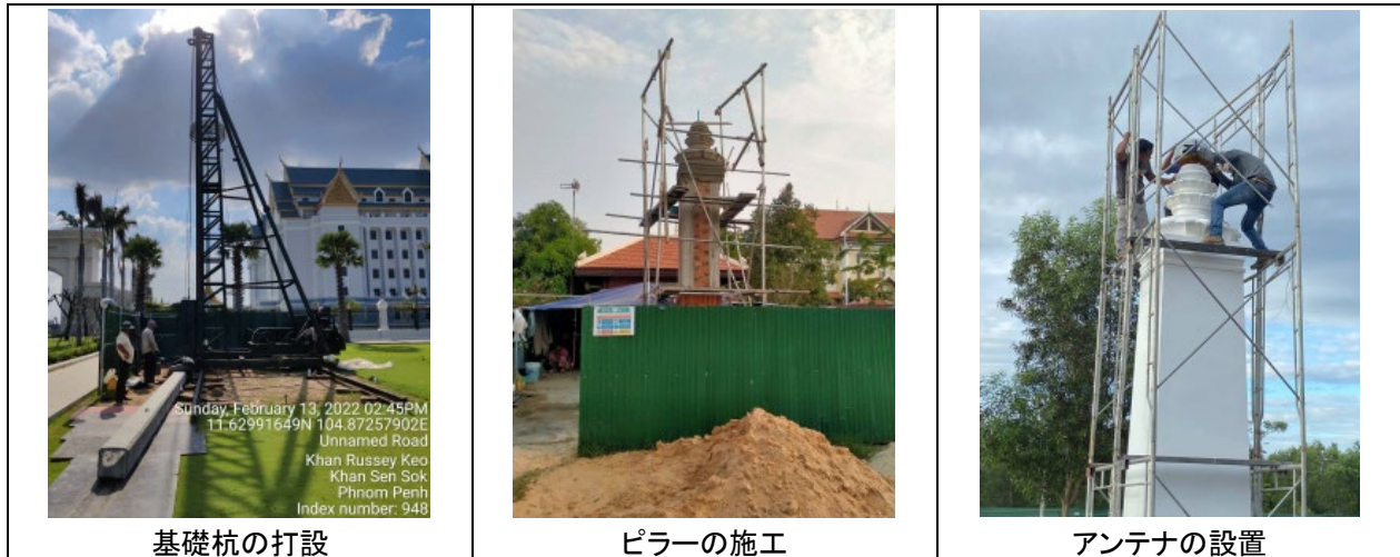
図 2-14 施工風景（撮影：CPT）
