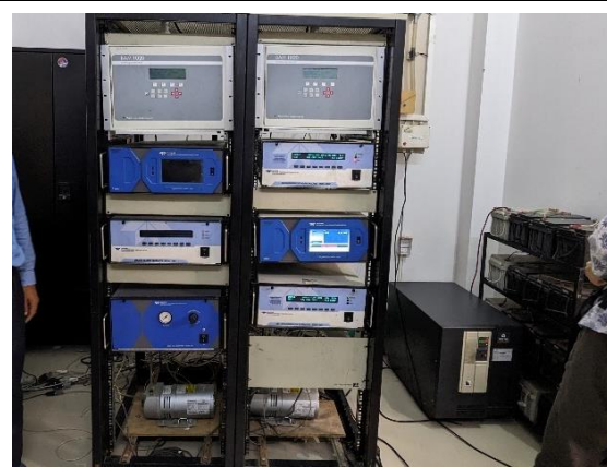
写真-4 DoE 本部の敷地内にある連続大気測定局建屋内の大気汚染測定装置一式（写真-3の2階に設置されている測定機一式）
