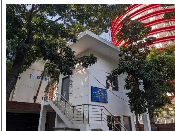
写真-3 DoE 本部の敷地内にある連続大気測定局建屋（2階建て、2階に測定機、1階に交換部品等が格納されている）
