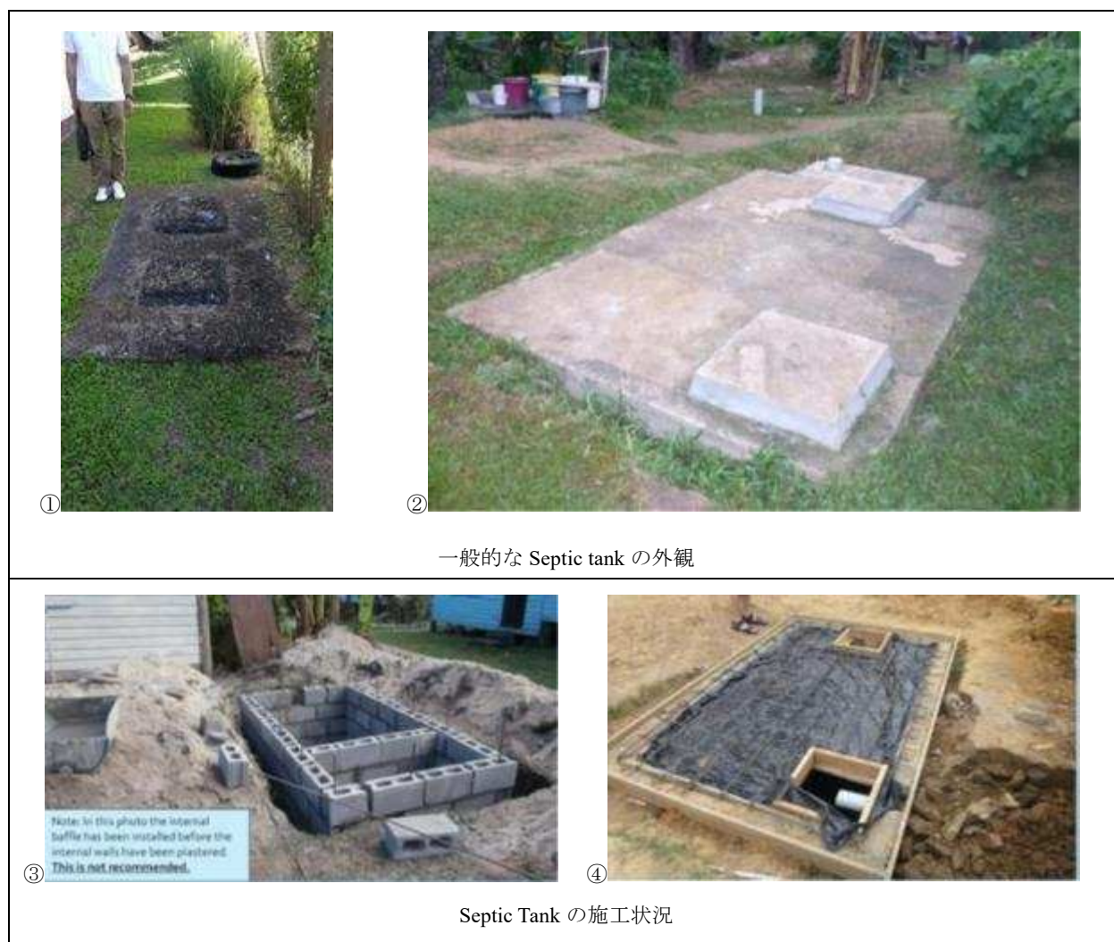
写真 4-2.1 Septic Tank の外観、施工写真
