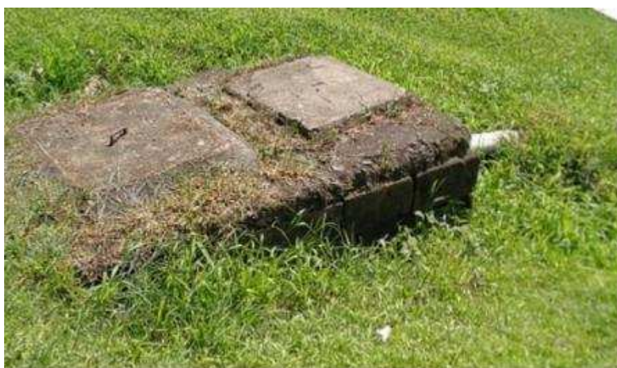
写真 4-2.3 ライニングが劣化した事例
