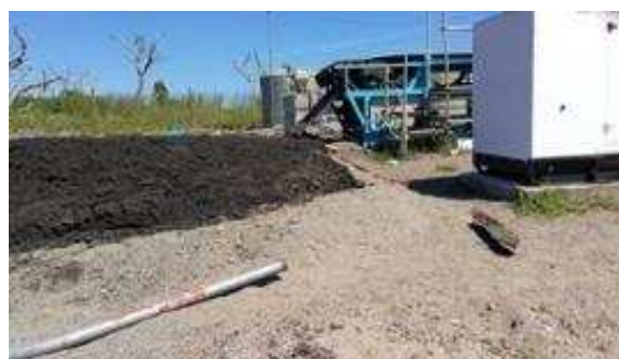
安定化池堆積汚泥の脱水処理
