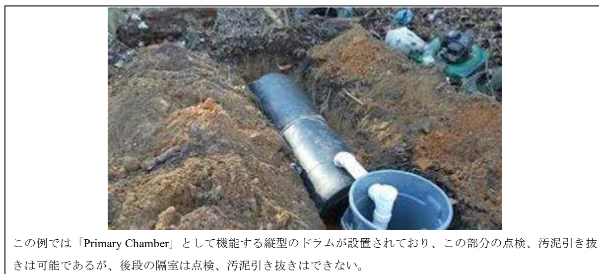
写真 4-2.2 Drum System の施工状況
