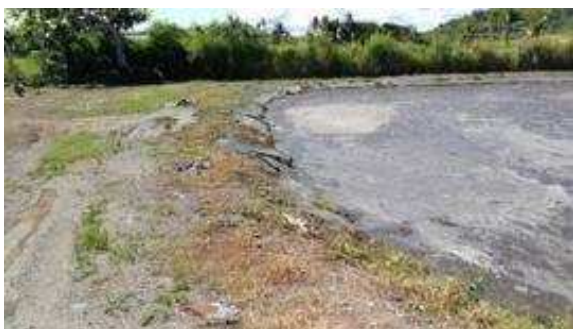
污泥投入位置
