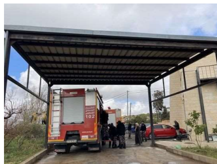
USAID 資金により 2015 年に整備された車庫 (ラムッラ県 Taybe 地域防災センター)
