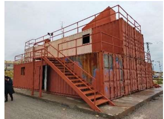
模擬消火・救助訓練棟 (内部には迷路、障害物、階段等が設置・降下訓練用としても使用)
